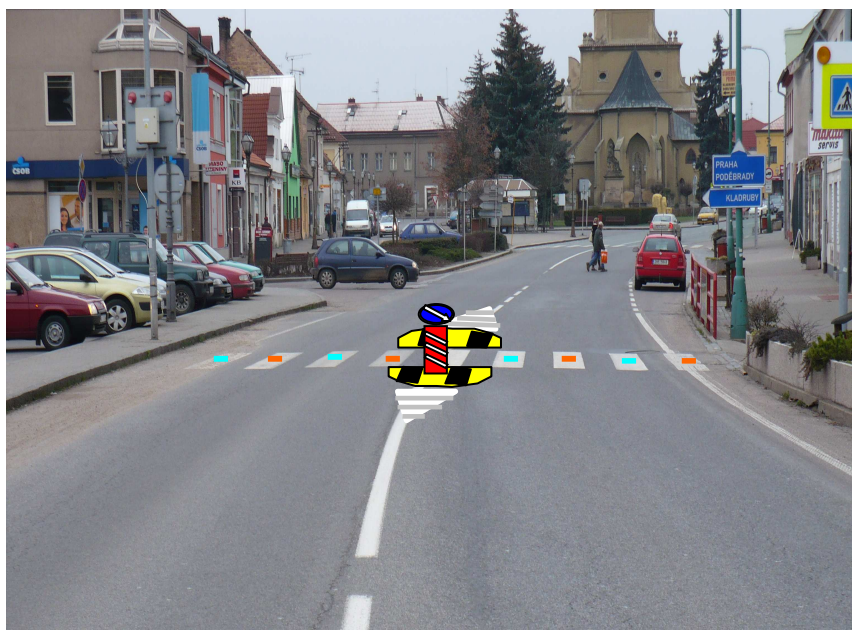
Obrázek č. 22: Přechod pro chodce před Základní uměleckou školou vybaven ochranným ostrůvkem
