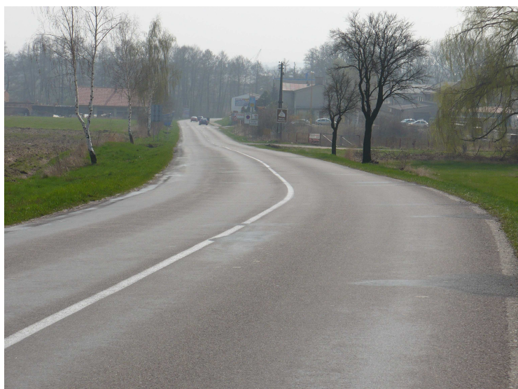
Obrázek č. 13: Vjezd do Chlumce nad Cidlinou ze směru od Nového Bydžova
