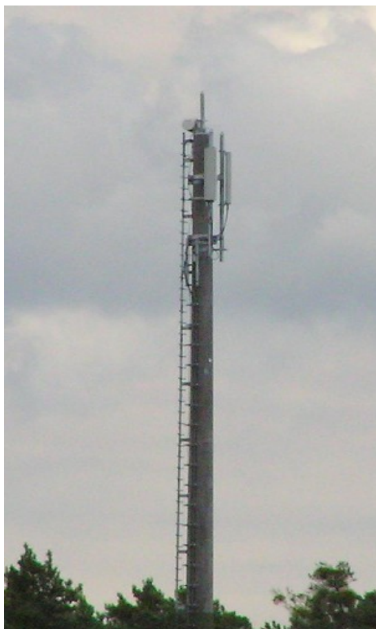
Obr.9: Stožár na kterém jsou umístěny směrové antény [7]
