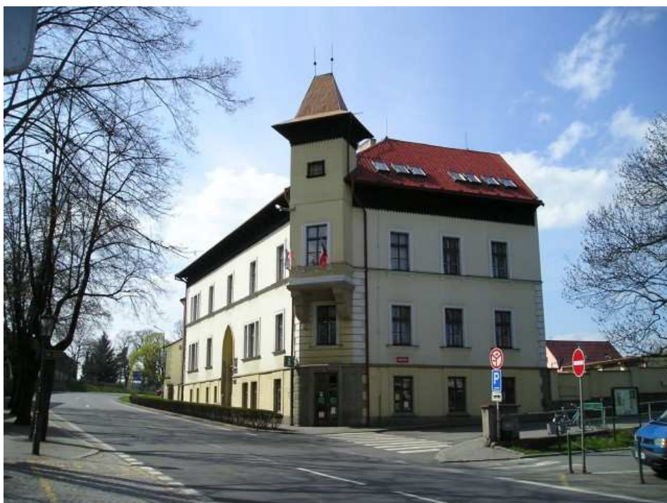
Obrázek 4 – Slatiňany: budova úřadu
