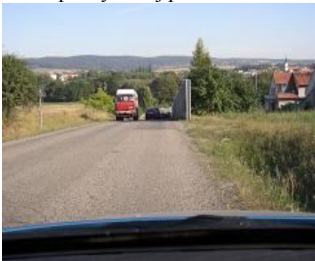
Nebezpečný okraj protihlukové stěny
