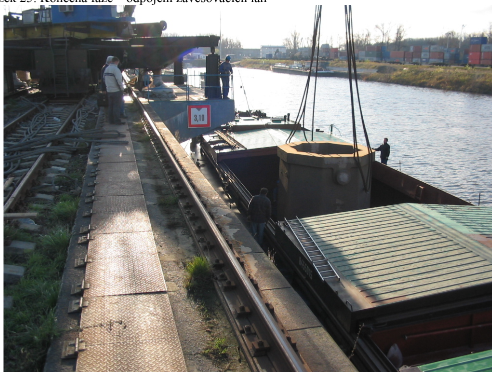
Obrázek 25: Konečná fáze – odpojení zavěšovacích lan
