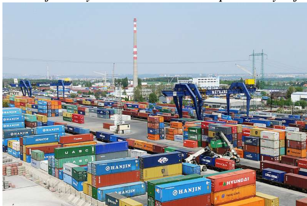
Obrázek č. 9: Kontejnerový terminál Metrans s portálovým jeřábem
