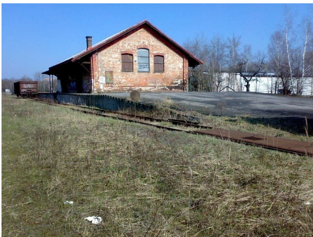
Obr. 2 Boční rampa se skladištěm a částí volné skládky u koleje č. 6
