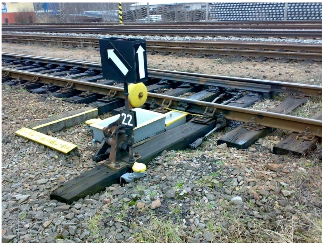
Obr. 15 Všechny výhybky jsou ovládány elektromotorem
