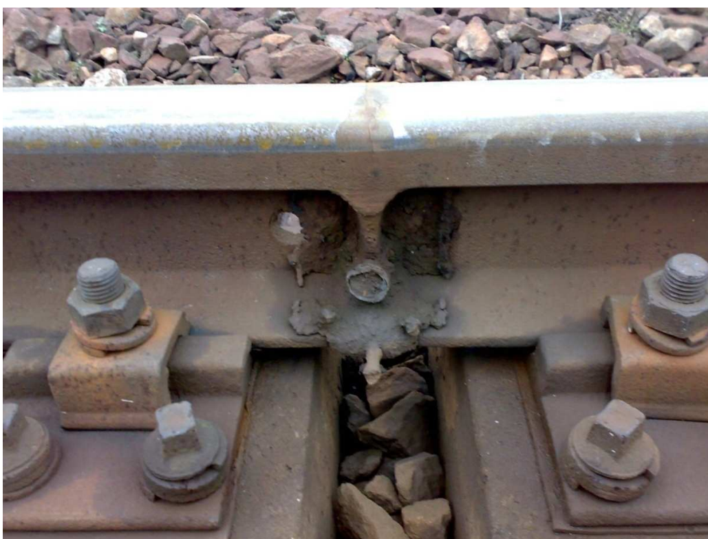
Obr. 8 Ukázka svaru termitem
