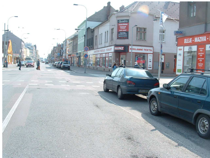
Obrázek 4: Celkový pohled na ulici Jana Palacha ve směru od centra
