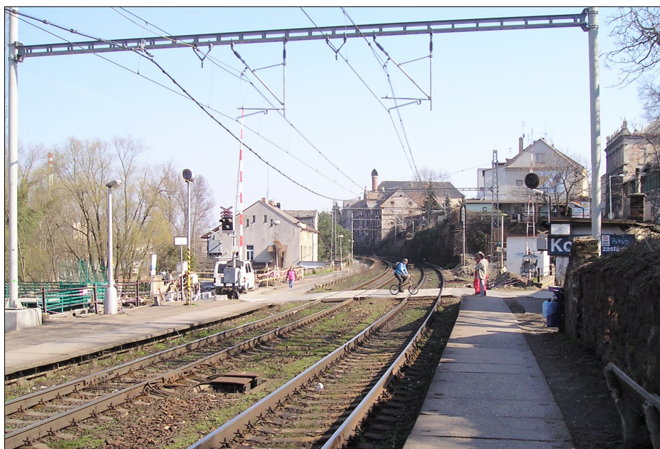
Obrázek č. 11 Pohled na železniční přejezd v km 349,202 železniční trati 501 Zdroj: Autor
