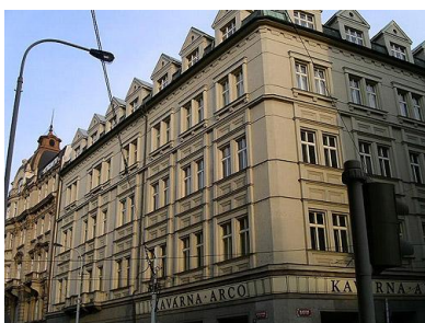
Obrázek 4 - Budova Institutu pro místní správu Praha
