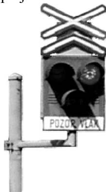
Obrázek č. 28: Výstražník světelného přejezdového zabezpečovacího zařízení
