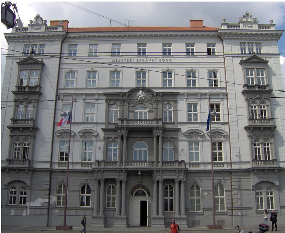
Obrázek 1: Budova Nejvyššího správního soudu v Brně
