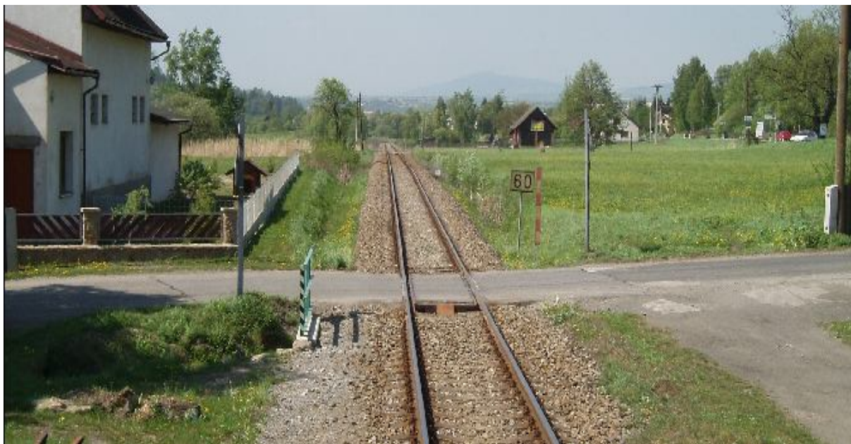
Obrázek 13: Železniční přejezd Borek pod Troskami
