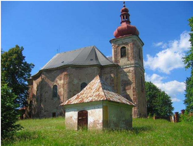
Obr. 16 Kostel Všech Svatých, Heřmánkovice
