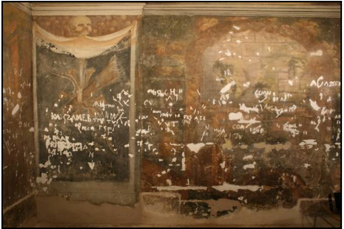
Obr. č. 52 Celkový pohled po vytmelení všech mechanických defektů
