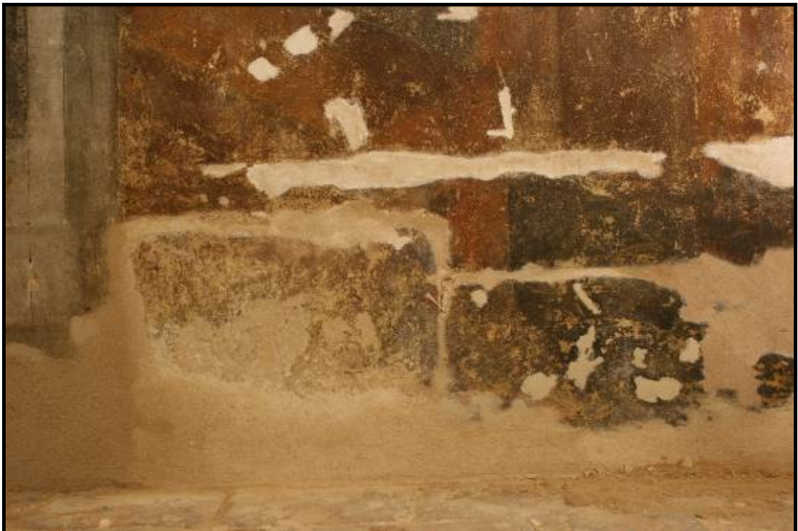
Obr. č. 44 Pohled na osazené a již téměř kompletně obtmelené transfery S7, S8
