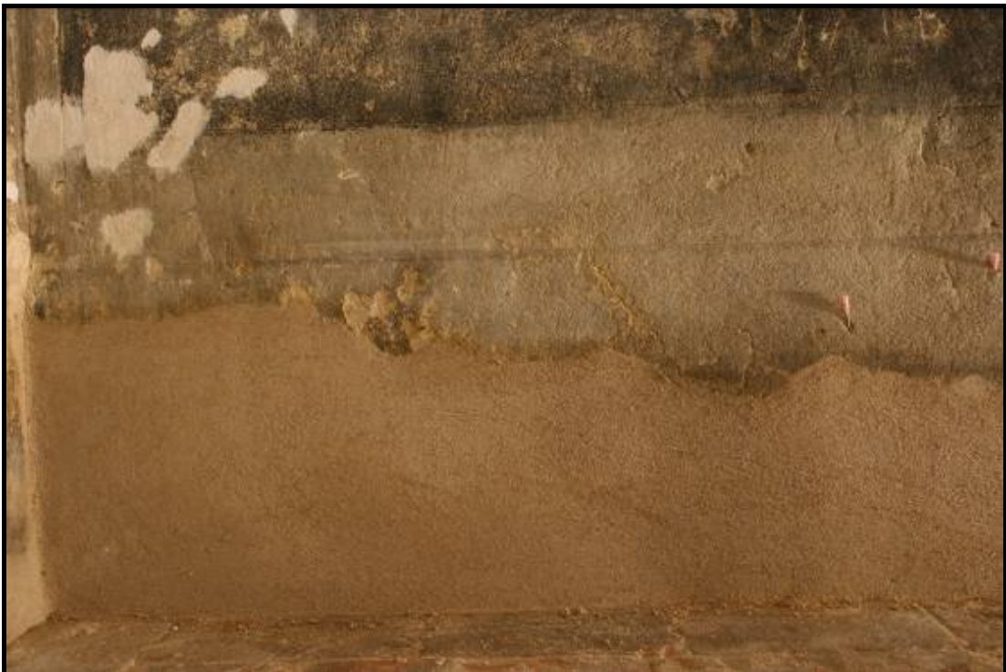
Obr. č. 46 Stav po doplnění chybějící hmoty omítky
