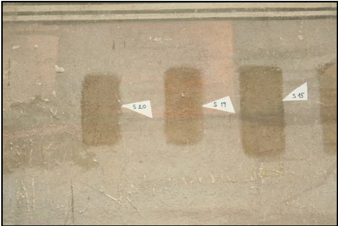
Obr. č. 19 Zkoušky čištění I – západní stěna
