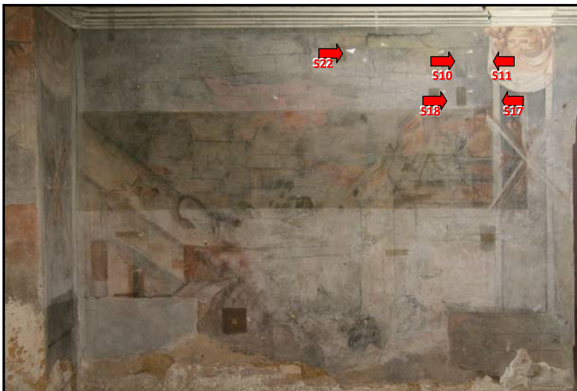
Obr. č. 17 Rozsáhlá obdélníková zkouška čištění suchou cestou (Wishab), sondy zkoušek čištění, zajištění pomocí přeplepu – spodní část, jižní stěna
