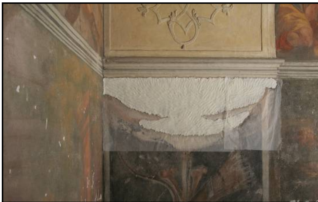
Obr. č. 35 Vrchní část pilíře, lokální dočišťování - prvním krokem – obklad 5% hydrogenuhličitanem amonným v Lovose přes Kashmir II po dobu 5 min, druhým krokem – odsolovací obklad na odstranění vzniklého síranu amonného-arbocel v destilované vodě přes Kashmir II
