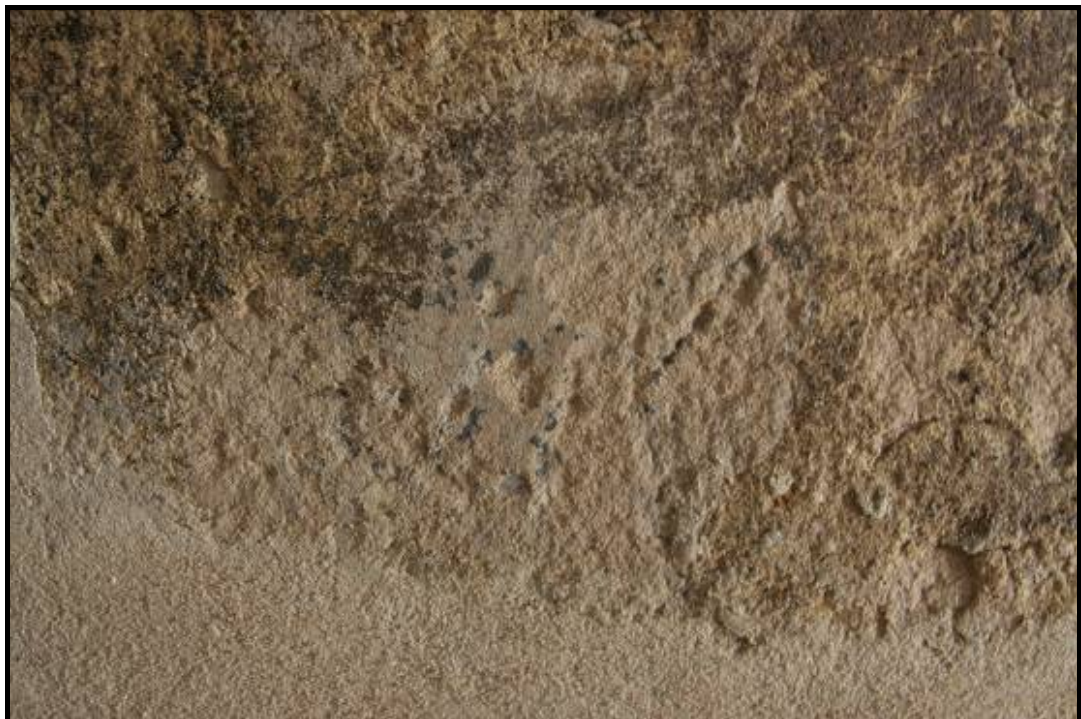
Obr. č. 40 Detail po odstranění tmelu
