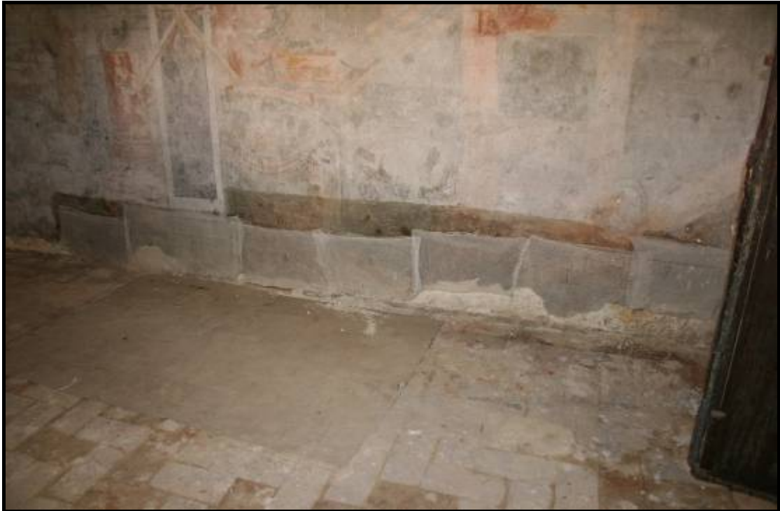
Obr. č. 25 Zajištění havarijních spodních částí malby pomocí gázových přelepů – severní stěna
