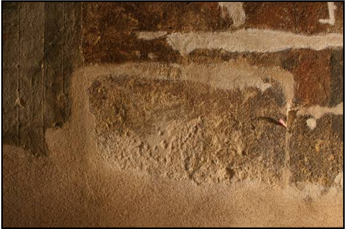
Obr. č. 43 Průběh obtmelování a tmelení transferu S8, místo injektáže ( Vapo inject)
