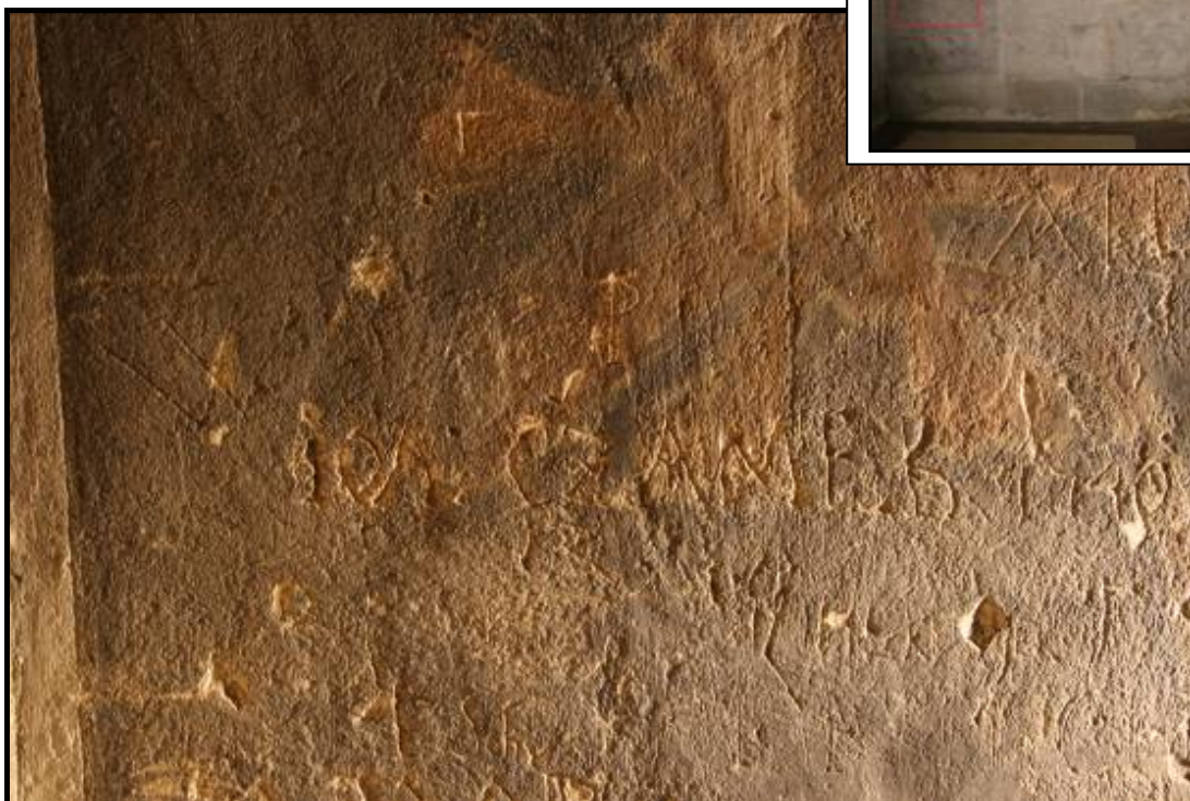
Obr. č. 24 Historické nápisy – graffiti, po odstranění tmelů, v bočním osvětlení
