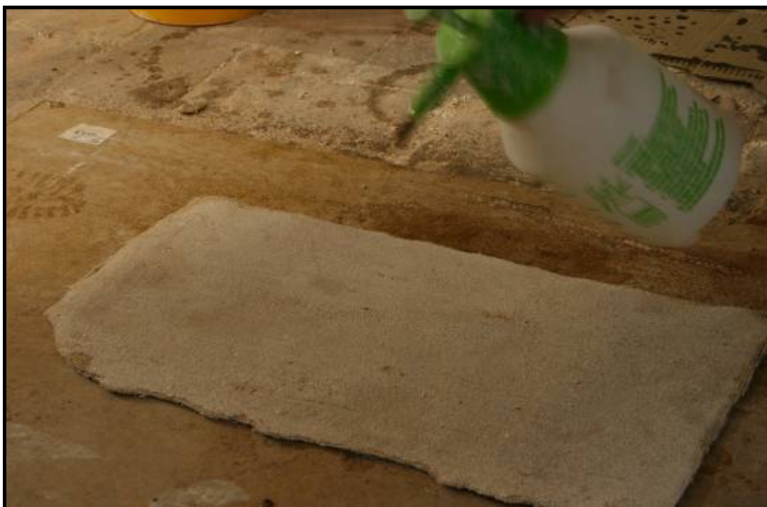
Obr. č. 32 Rubová strana transferu s vrstvou omítky (1:2), do které byla vložena skelná mřížka pro celoplošné vyztužení transferů.
