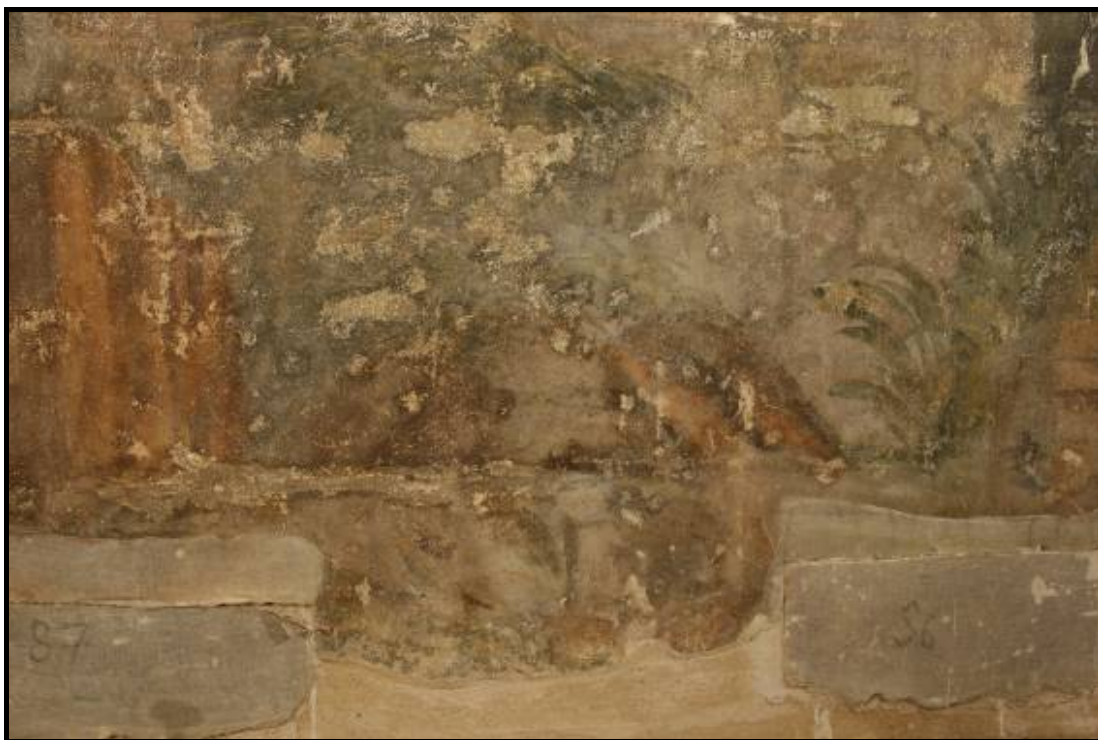
Obr. č. 22 Mechanická poškození – vrypy, škrábance, historická graffiti; chybějící barevná vrstva; místa s bílým zákalem, osazené transfery
