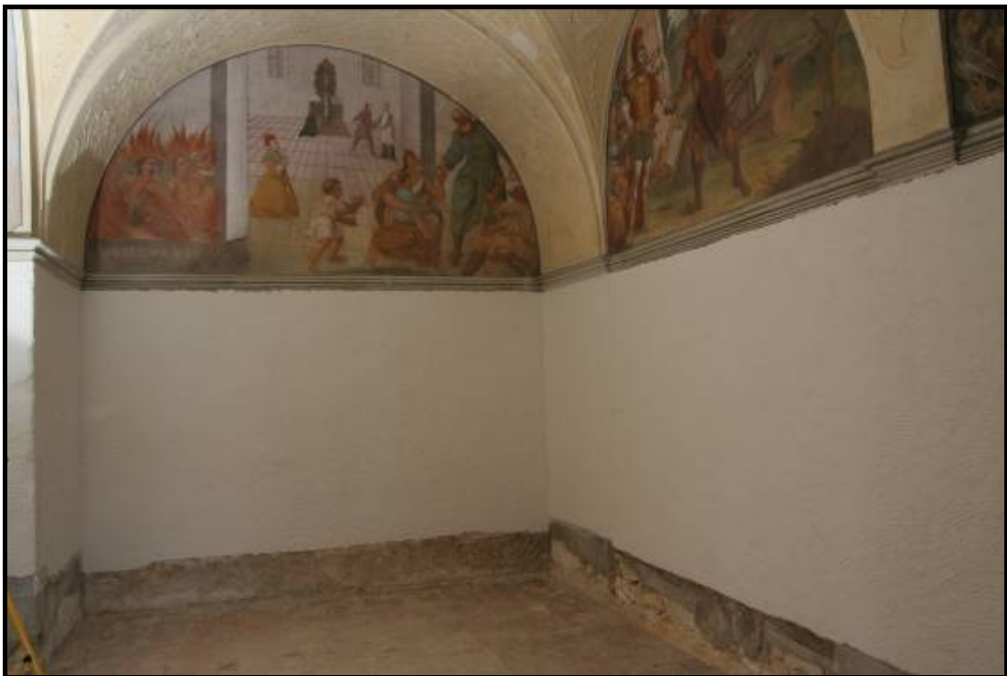
Obr. č. 18 Kompletní zakrytí arbocelovým obkladem – severní a západní stěna
