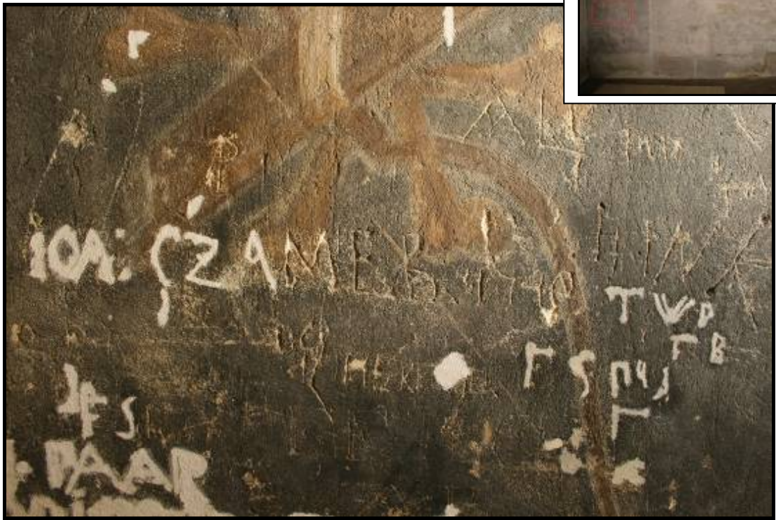
Obr. č. 47 Proces tmelení, pilíř – severní stěna
