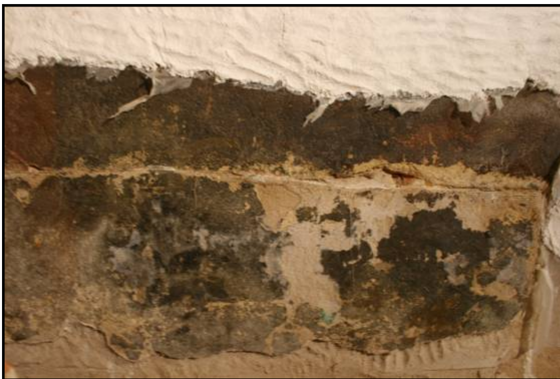
Obr. č. 37 Transfer S7 po osazení a sejmutí ochranného přelepu
