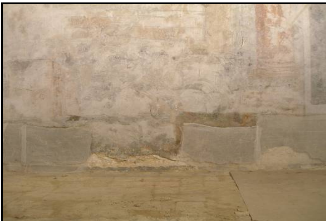
Obr. č. 2 Zajištění malby pomocí gázových přelepů – severní stěna, přidělený úsek
