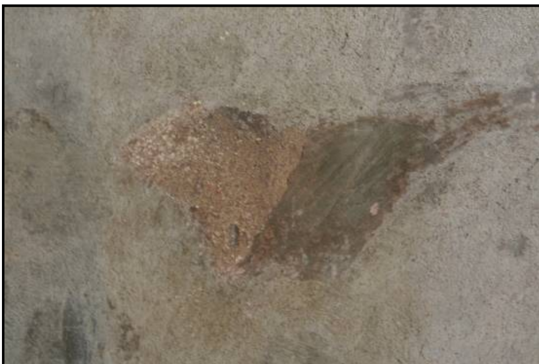
Obr. č. 10 Místa po odstranění druhotně vytvořených tmelů, severní stěna – přidělený úsek
