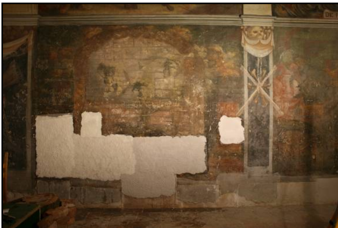
Obr. č. 34 Celkový pohled po osazení transferů, lokální dočištění - prvním krokem – obklad 5% hydrogenuhličitanem amonným v Lovose přes Kashmir II po dobu 5 min, - druhým krokem – odsolovací obklad na odstranění vzniklého síranu amonného-arboceľ v destilované vodě přes Kashmir II
