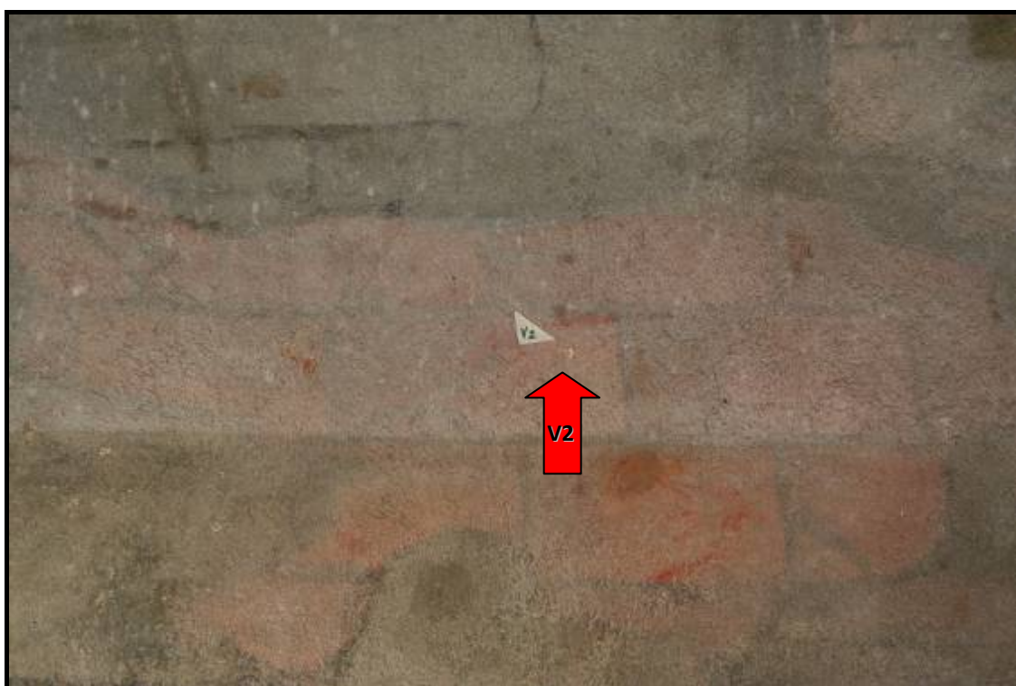
Obr. č. 22 Místo odběru vzorku barevné vrstvy (vzorek č. 2) – jižní stěna
