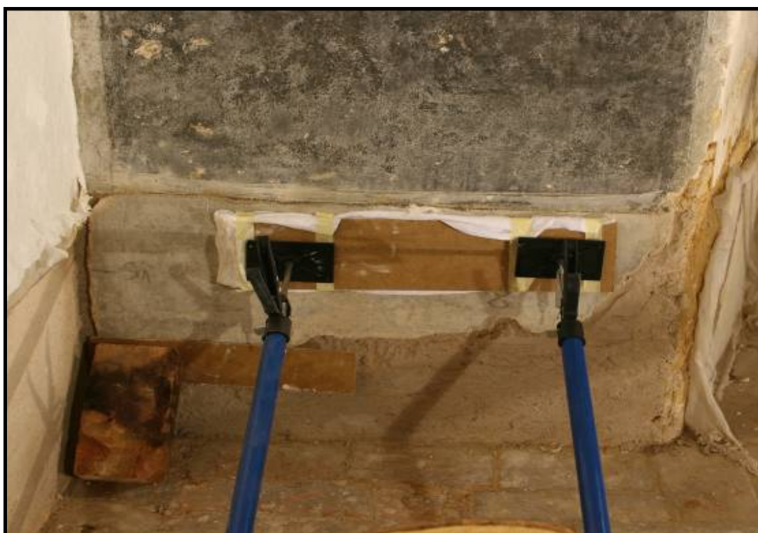
Obr. č. 33 Osazený transfer zabezpečený teleskopickými tyčemi
