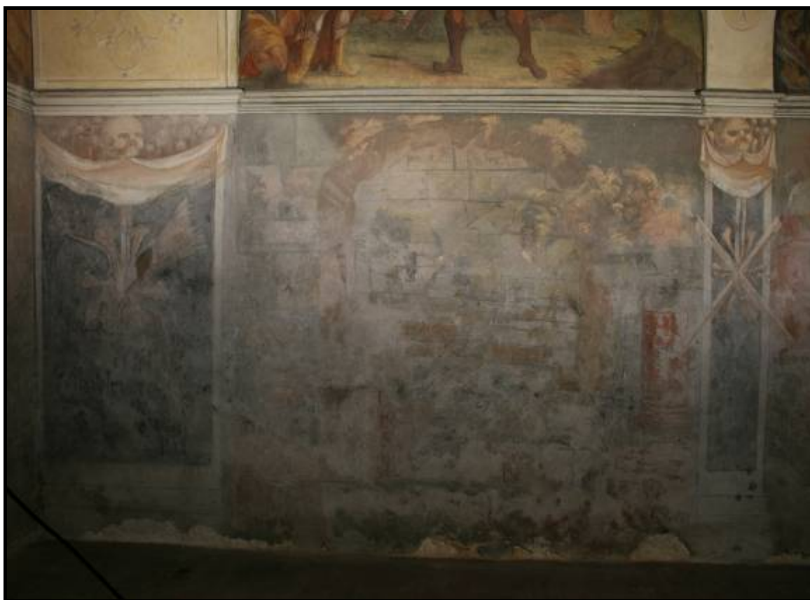
Obr. č. 1 Celkový pohled před restaurováním – severní stěna
