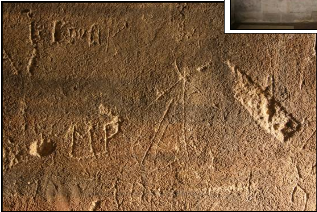
Obr. č. 26 Mechanická poškození – vrypy, škrábance, graffiti, v bočním osvětlení
