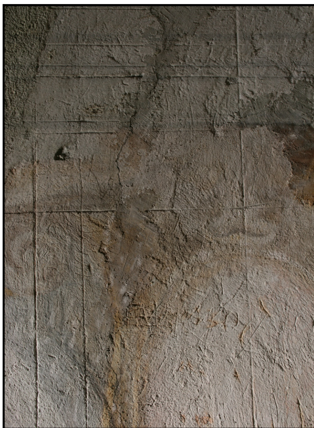
Obr. č. 14 Detail - rytá geometrická kresba, tmel, v bočním osvětlení – západní stěna
