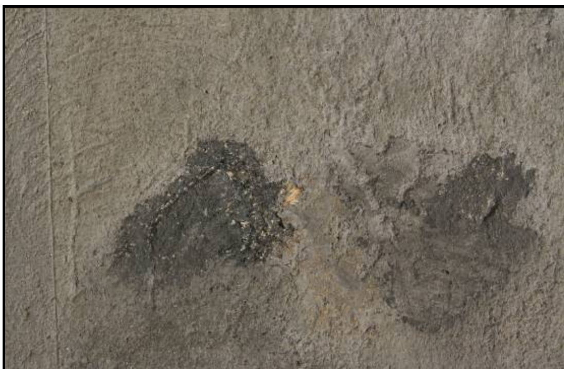
Obr. č. 13 Detail průběhu odstraňování druhotných probarvených tmelů, severní stěna – přidělený úsek
