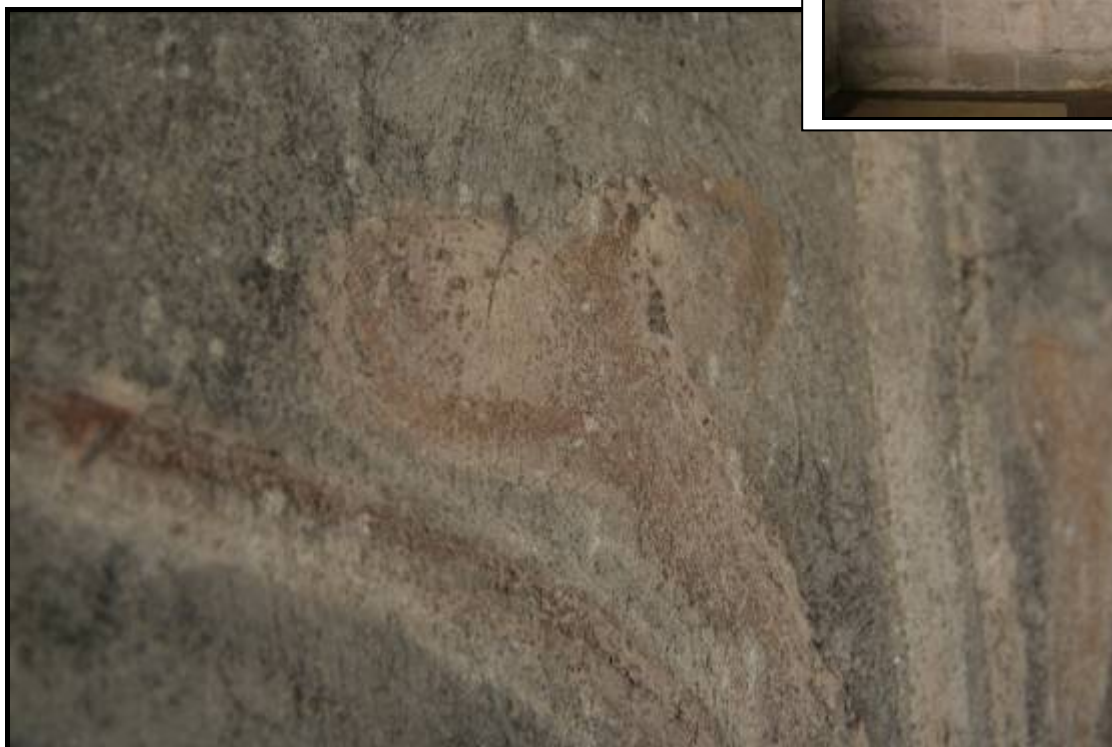
Obr. č. 5 Detail zpráškovatělé barevné vrstvy s bílým zákalem; stav před restaurováním; pilíř; severní stěna
