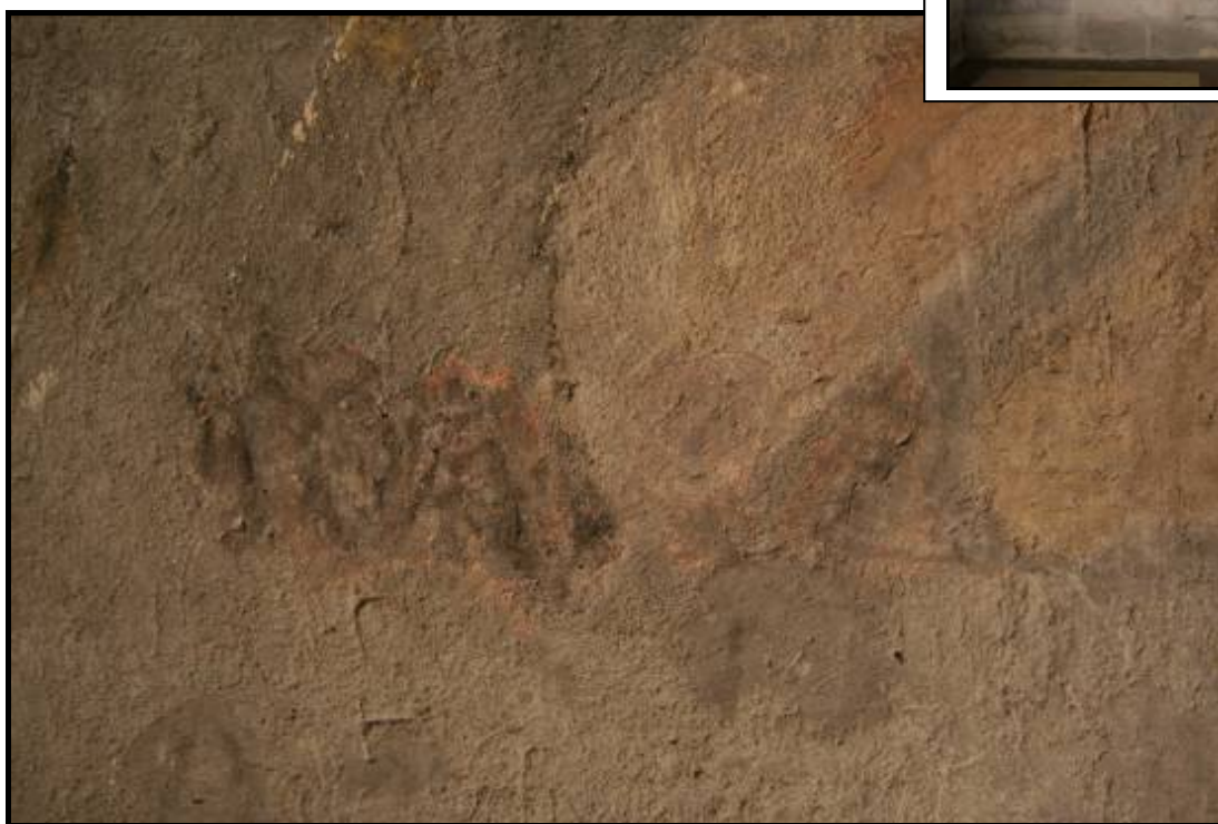
Obr. č. 7 Detail novodobého tmelu s bílým zákalem, stav před restaurováním; pilíř; severní stěna
