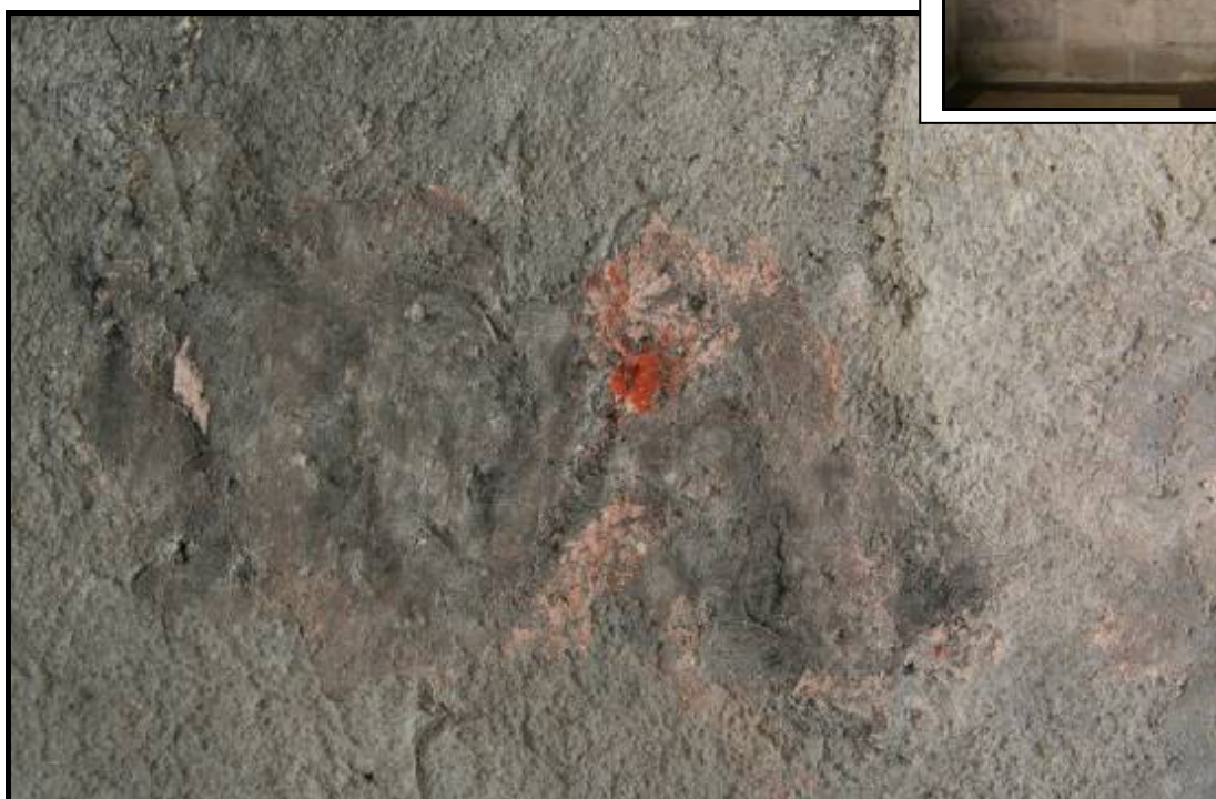
Obr. č. 12 Detail průběhu odstraňování druhotných probarvených tmelů, severní stěna – přidělený úsek
