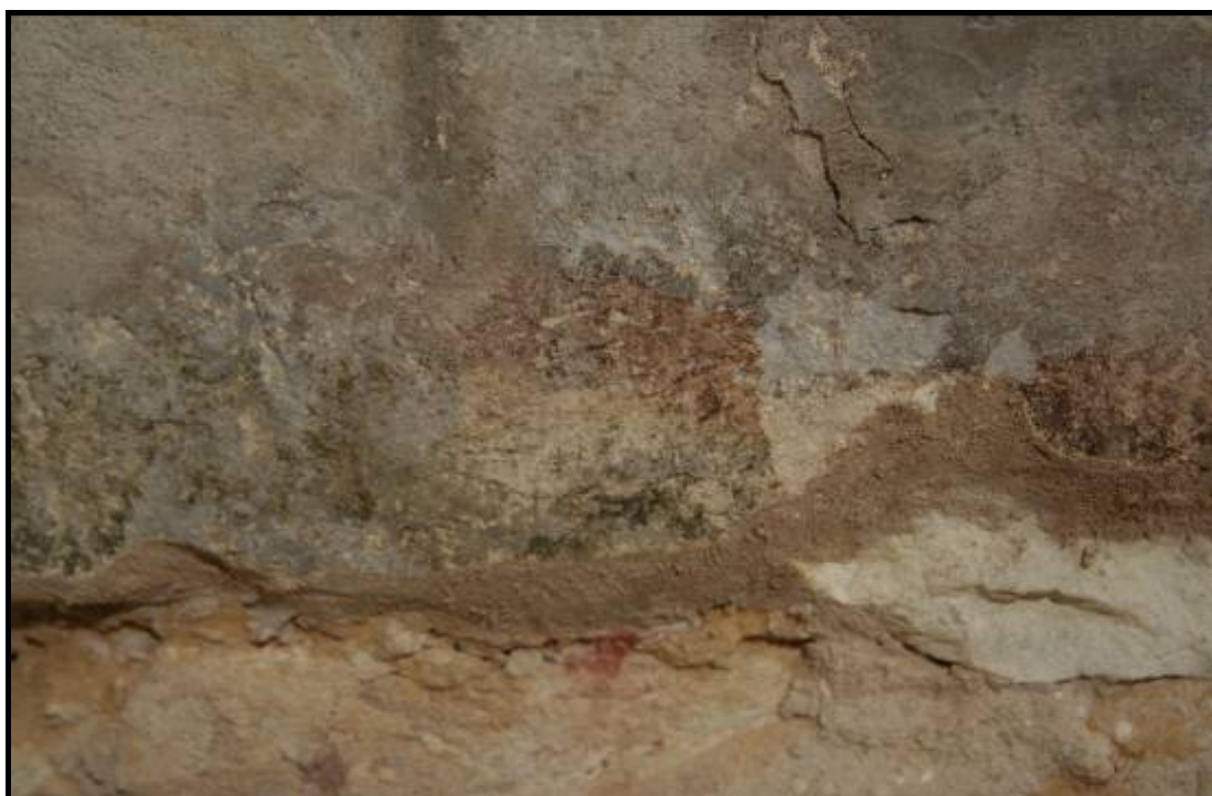
Obr. č. 31 Detail obtmelování okrajů spodních částí malby
