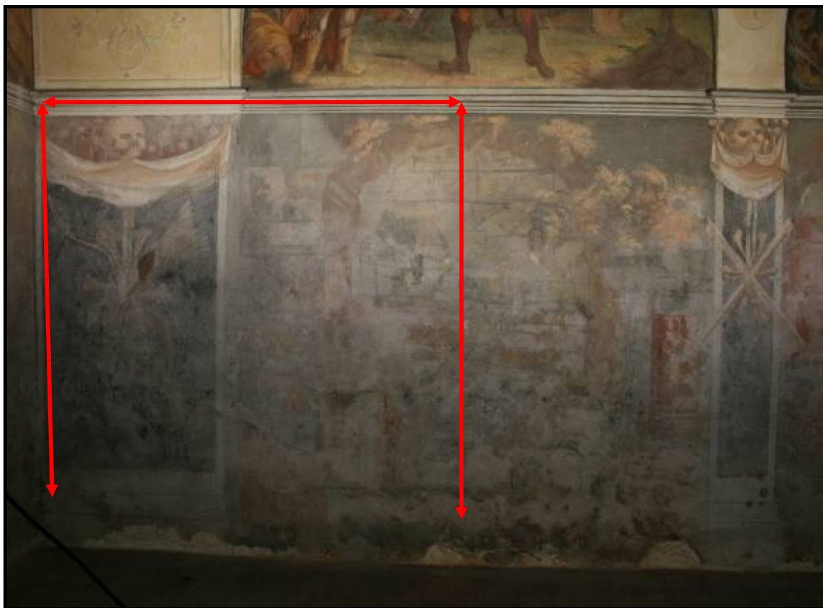
Obr. č. 2 Vyznačení konkrétního přiděleného úseku, stav před restaurováním, severní stěna
