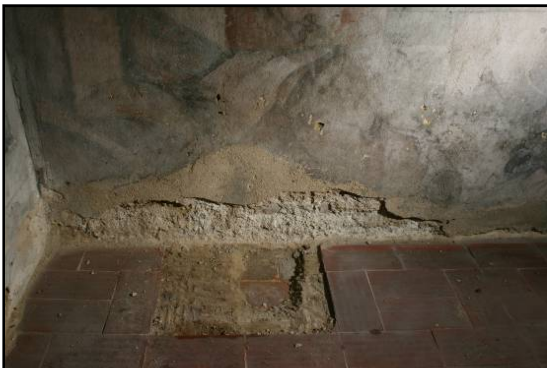
Obr. č. 27 Sonda podlahy, pod svrchní dlažbou betonové lože, pod ní původní cihelná dlažba, východní stěna
