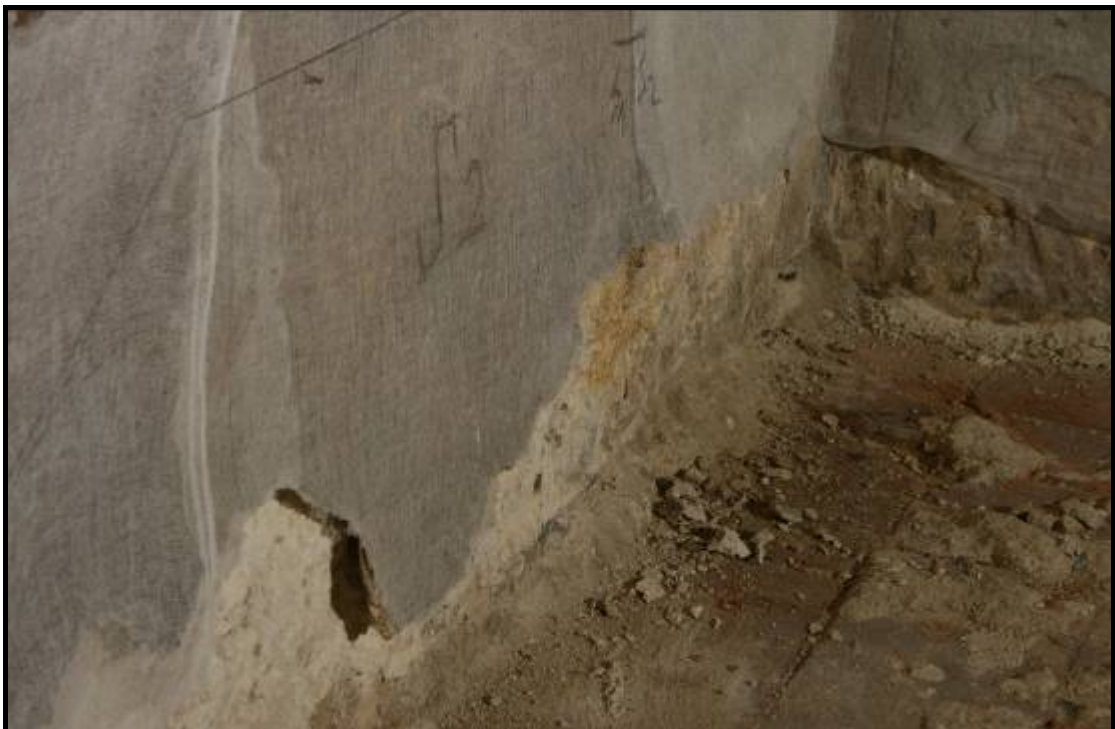
Obr. č. 26 Detail zajištění malby pomocí gázových přelepů – severní stěna
