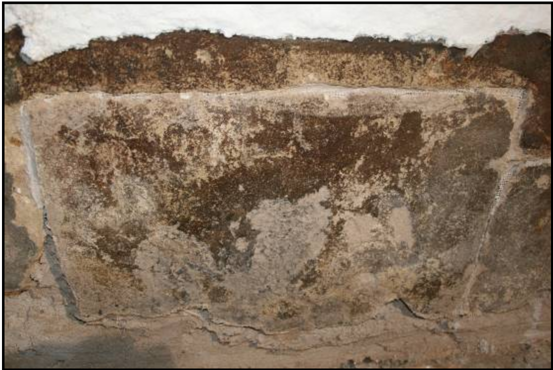
Obr. č. 39 Transfer S8 po osazení a sejmutí ochranného přelepu, po odstranění sádrových tmelů
