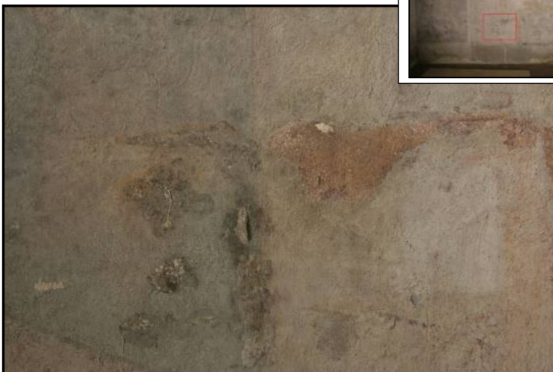
Obr. č. 10 Místa po odstranění druhotně vytvořených tmelů, severní stěna – přidělený úsek
