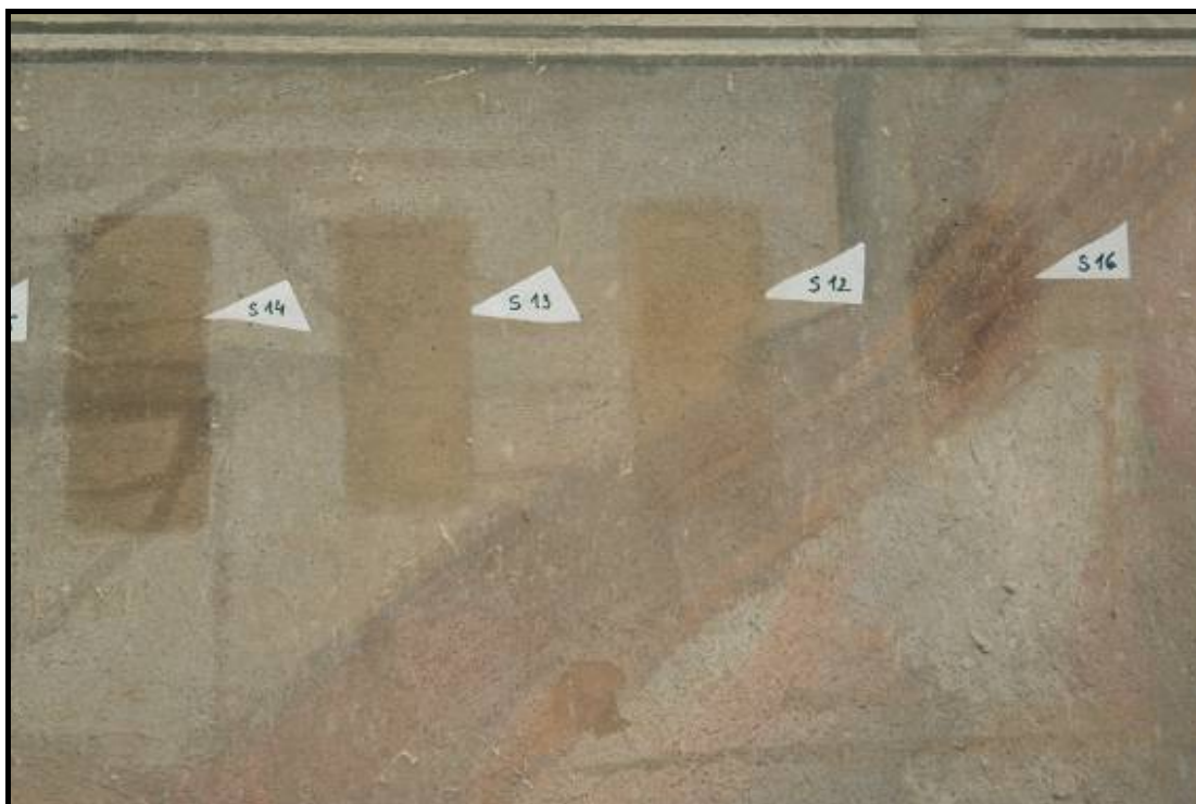
Obr. č. 20 Zkoušky čištění II – západní stěna
