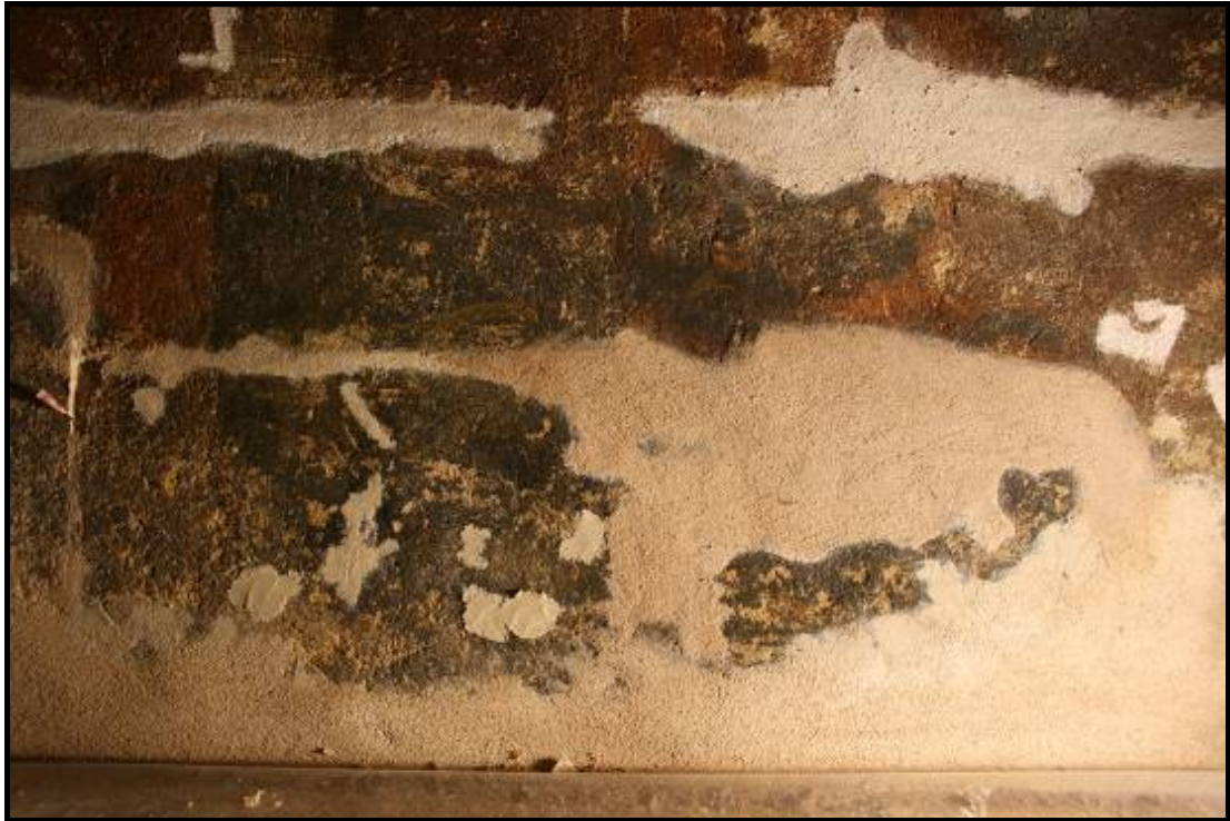
Obr. č. 41 Průběh obtmelování a tmelení transferu S7
