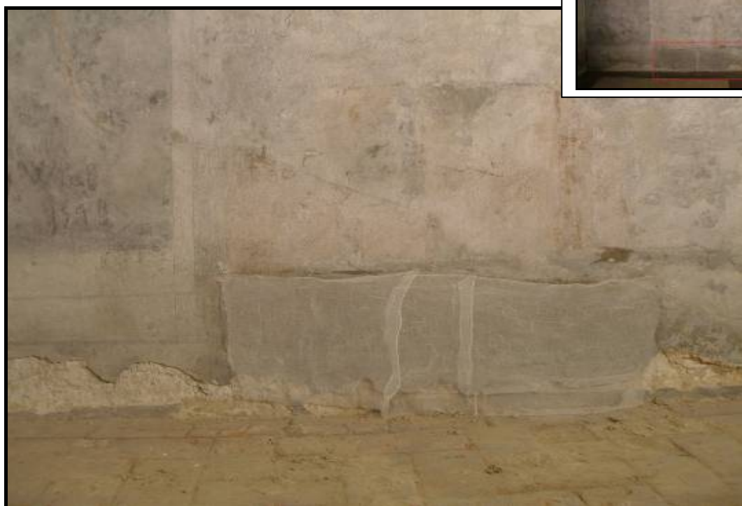
Obr. č. 1 Zajištění malby pomocí gázových přelepů – severní stěna, přidělený úsek
