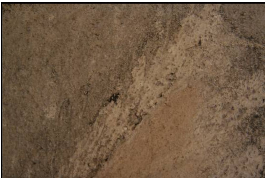
Obr. č. 6 Detail zpráškovatělé barevné vrstvy s bílým zákalem, stav před restaurováním; pilíř; severní stěna
