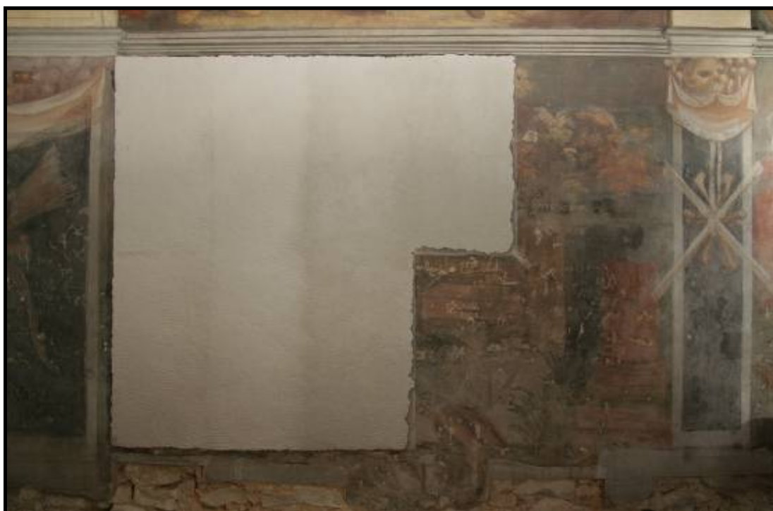
Obr. č. 15 Průběh čištění mokrou cestou – arbocelový obklad s destilovanou vodou přes Kashmir II
