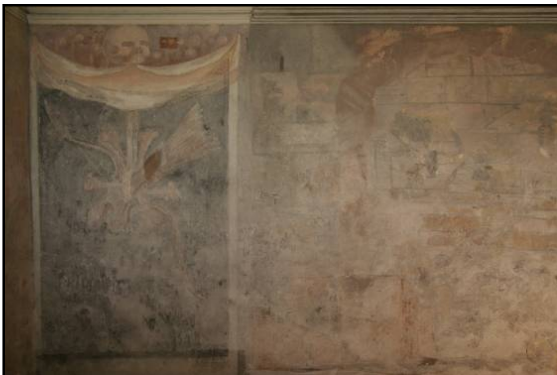
Obr. č. 3 Úsek přidělené části malby, stav před restaurováním – severní stěna – pilíř a část centrálního výjevu malby
