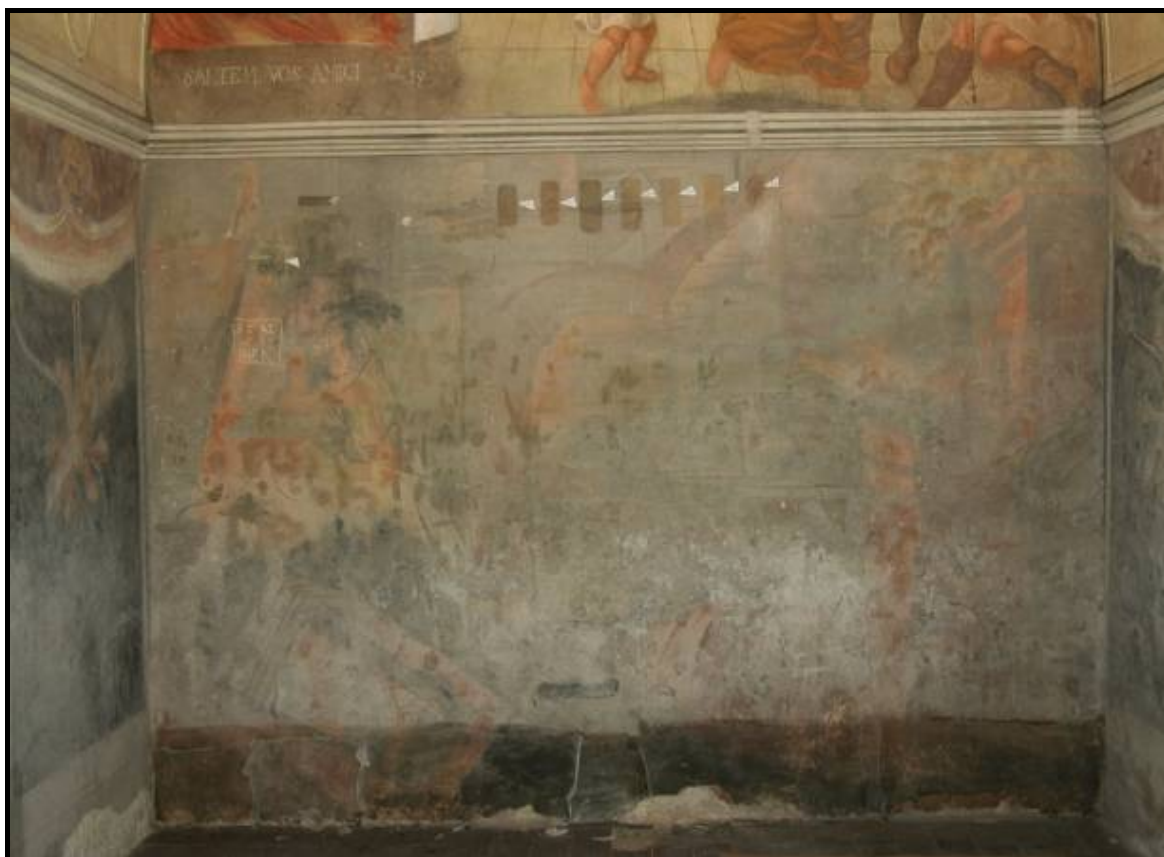
Obr. č. 18 Zkoušky čištění, zajištění malby pomocí přelepů ve spodní části – západní stěna
