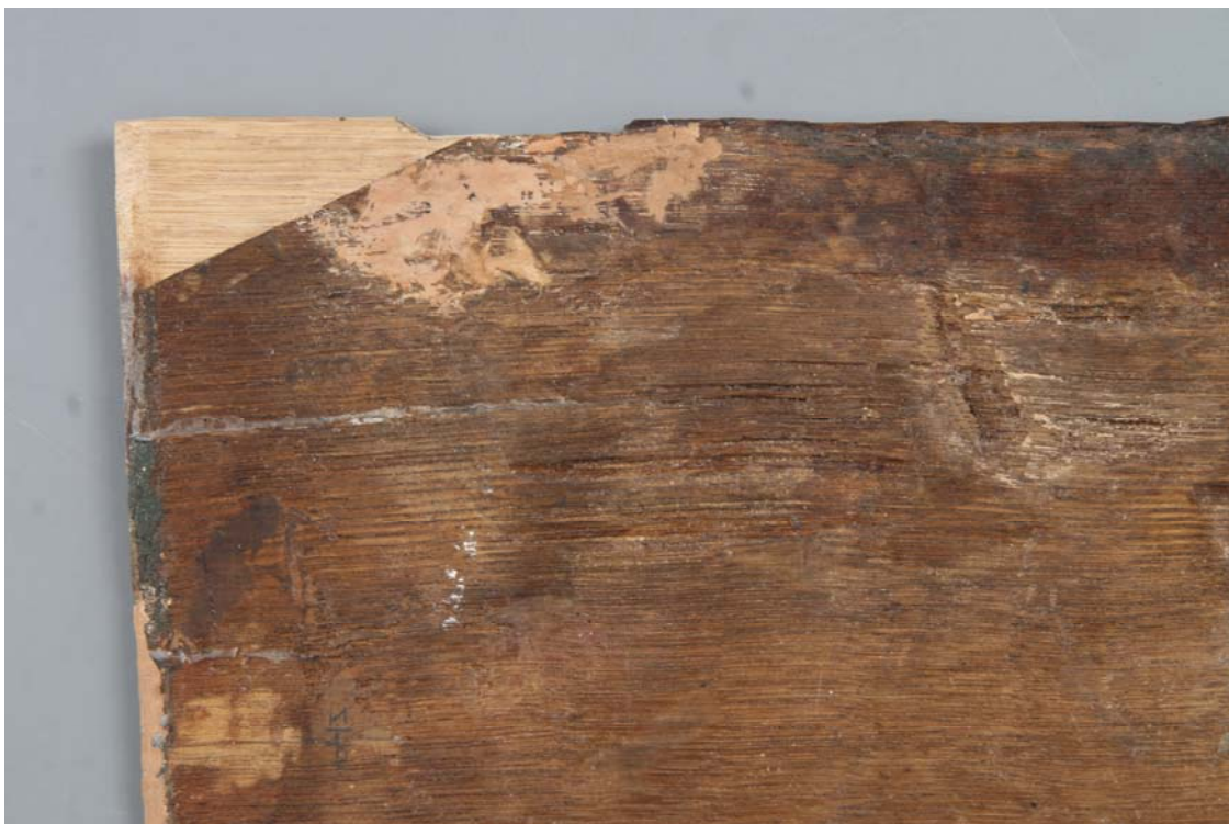
(Obr. 75) Detail rohu – stav po restaurování
