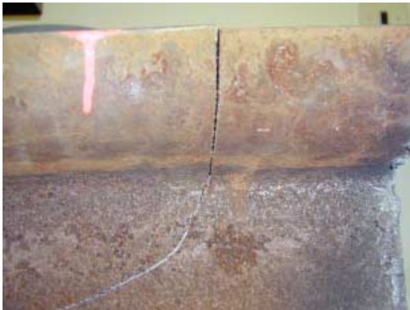
Obr. 1: Průběh trhliny, která vychází z hlavy tramvajové kolejnice a směřuje napříč profilem s charakteristickým vybočením v oblasti stojiny kolejnice.
