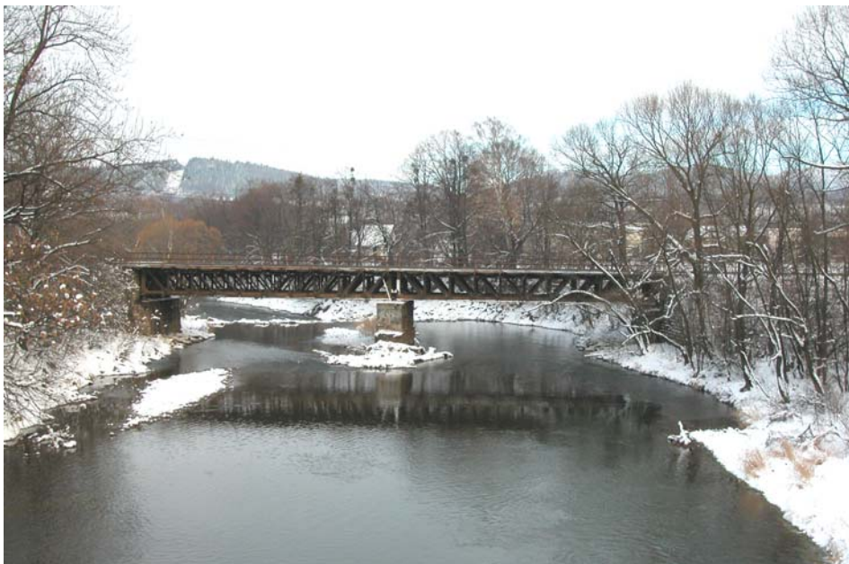
Fig. 1 Bridge across Olše river in Vendryně (km 308,174), which will be reconstructed Obr. 1 Most přes řeku Olši ve Vendryni (dráž. km 308,174), který bude rekonstruován
