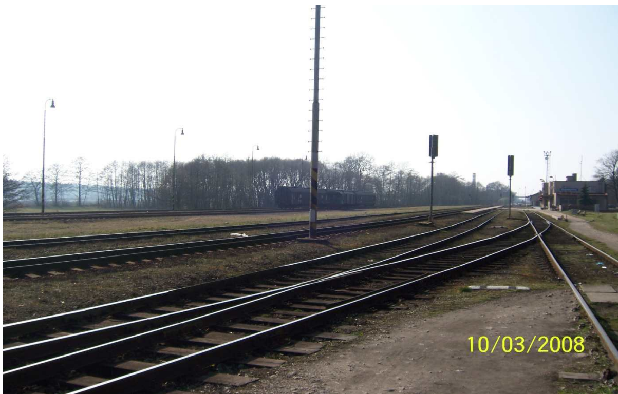
3. Pohled na Výpravní budovu z pravé strany
