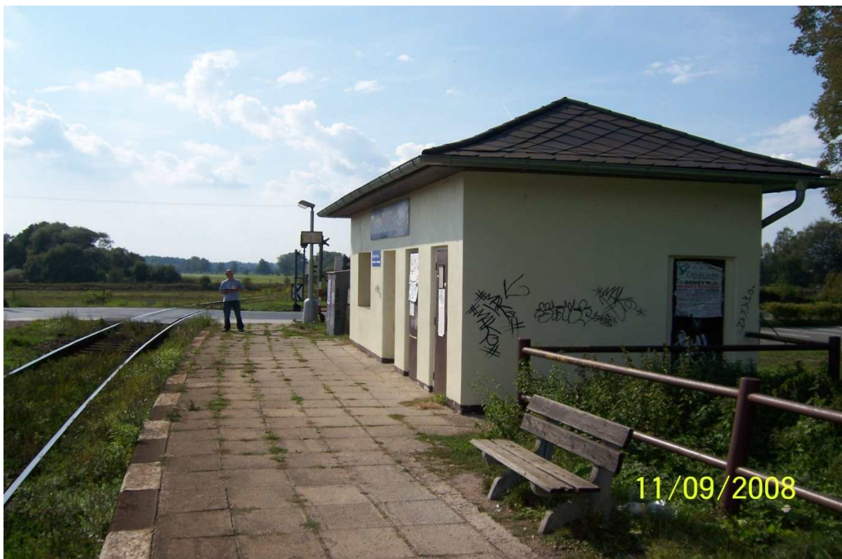
3. Železniční přejezd mezi zastávkou Častolovice a železniční stanicí Častolovice
