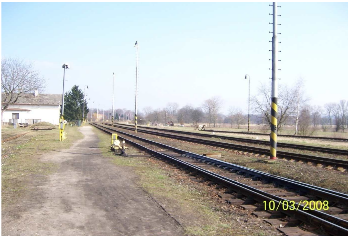
2. Pohled z pravé strany na stanici Častolovice
