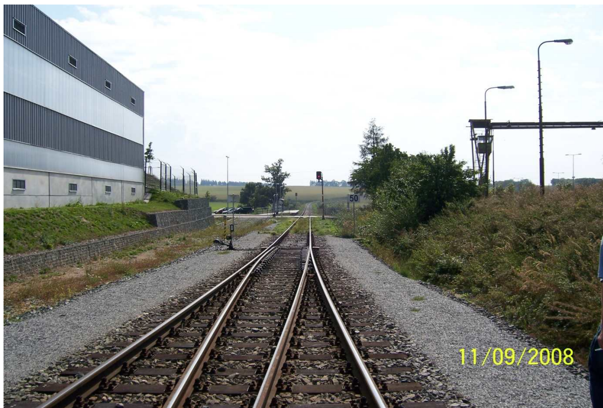
10. Pohled přejezd mezi železniční stanicí Solnice a zastávkou Solnice
