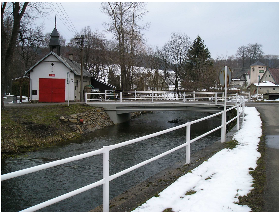
Obrázek 11: Železobetonový most přes řeku Chrudimku - střed obce Hamry
