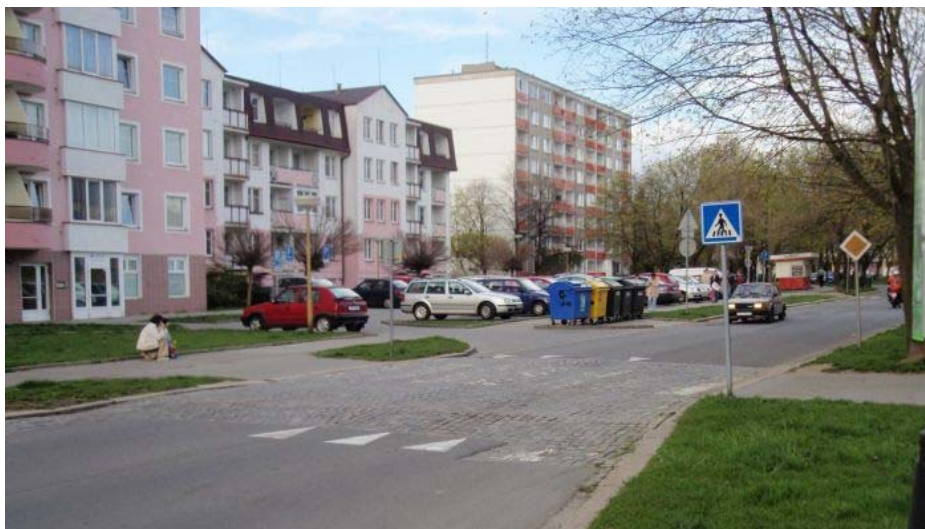
Obrázek 12: Zvýšená plocha vozovky přechodu pro chodce v ulici Kozlovská v Přerově
