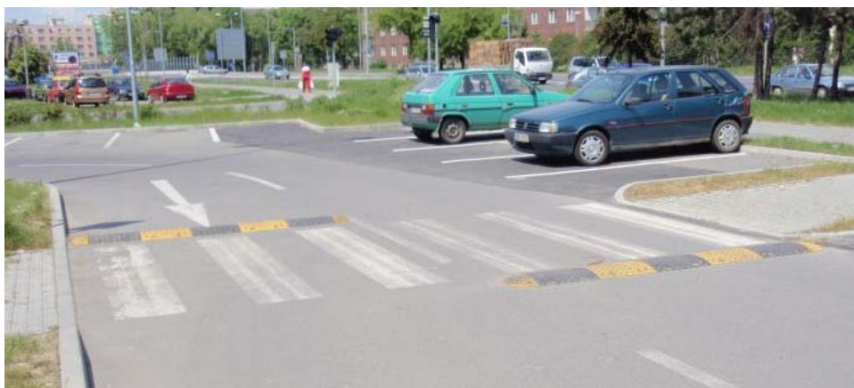
Obrázek 14: Zpomalovací práh z montovacích dílců
