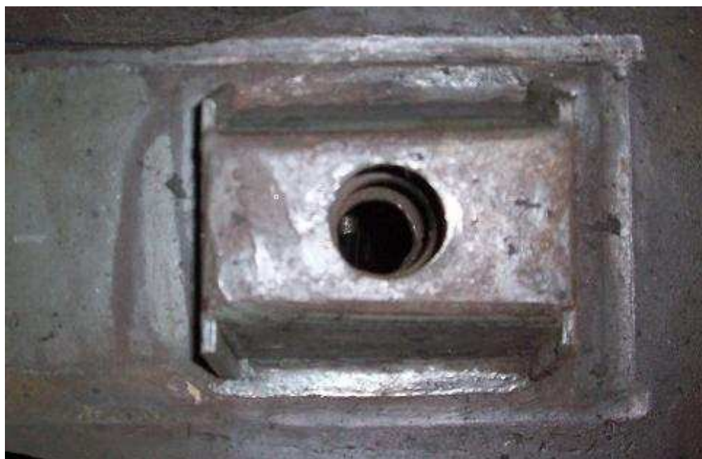
Obr.:41. Viditelné opotřebení povrchu torzní vzpěry
