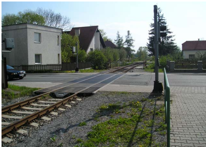
Železniční přejezd v obci Dolní Roveň
