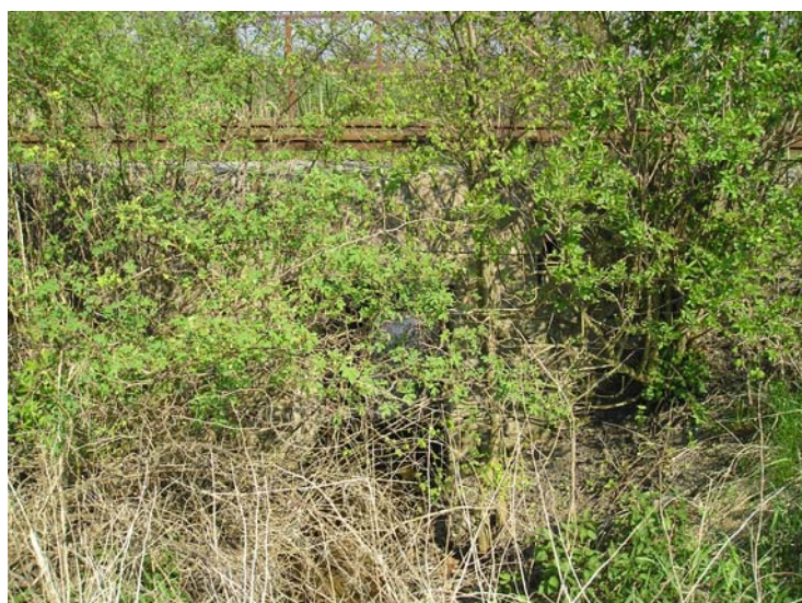
Propustek na 32,281 km
