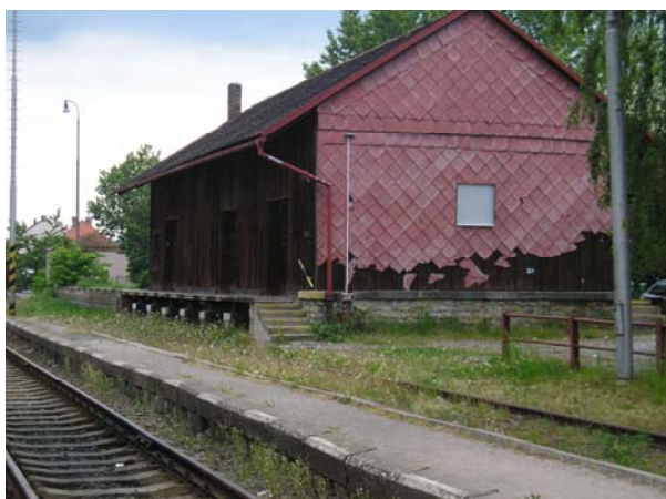
Železniční stanice Holice – skladiště
