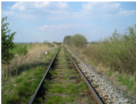
Pohled směr Moravany na 32,500 km
