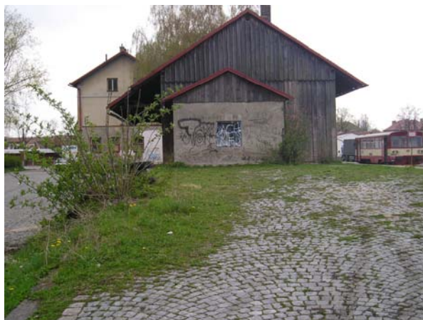
Železniční stanice Holice – skladiště
