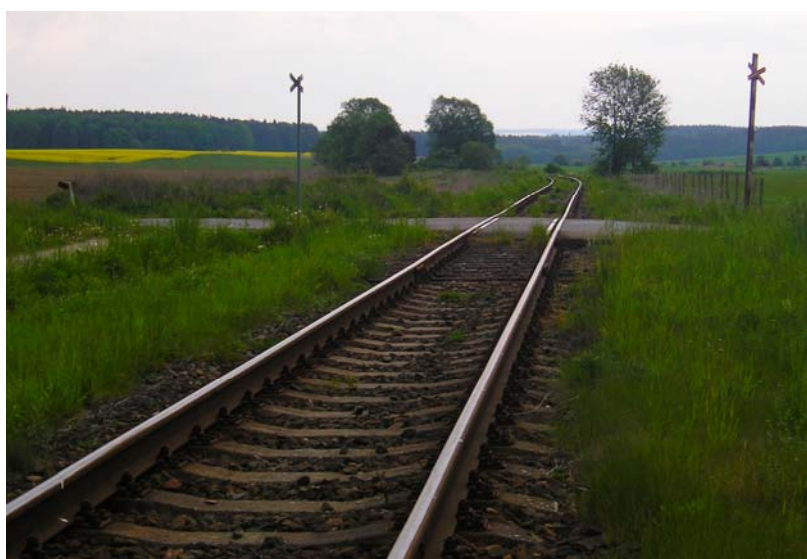
Pohled směr Borohrádek, přejezd na 42,773 km
