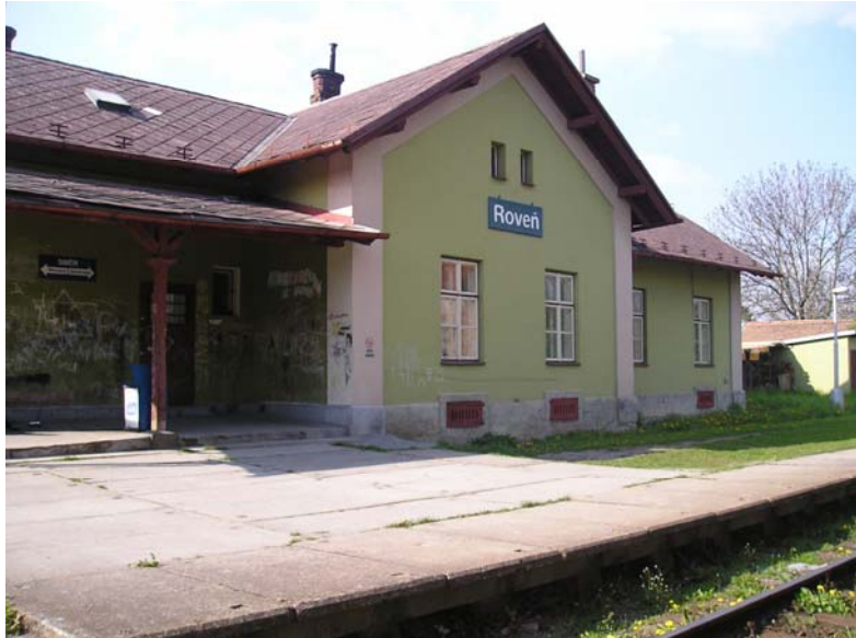
Železniční zastávka Dolní Roveň 33,648 - 33,698 km
