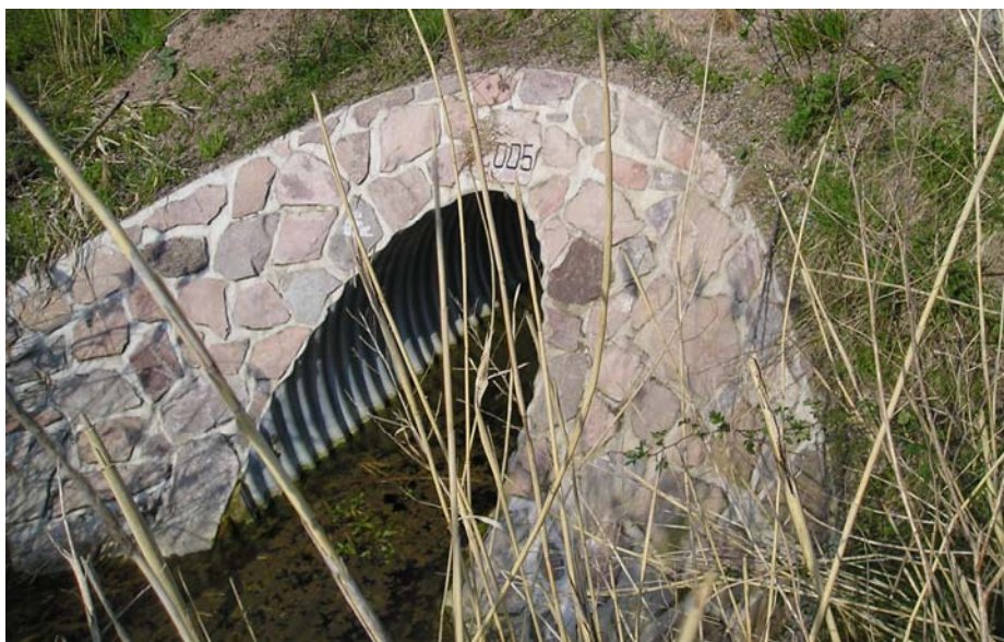
Zrekonstruovaný propustek na 37,087 km
