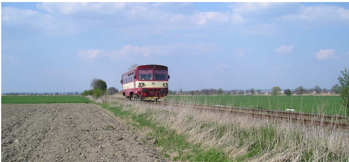
Pohled směr Borohrádek na 31,700 km
