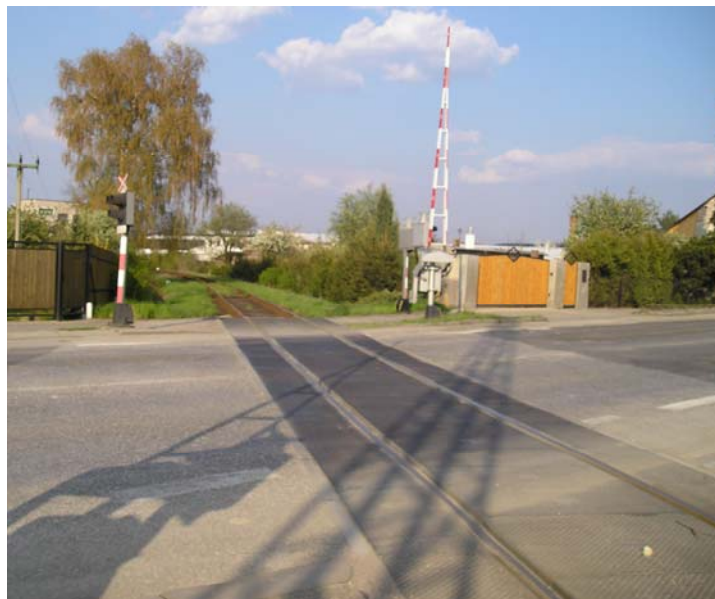
Železniční přejezd v obci Holice
