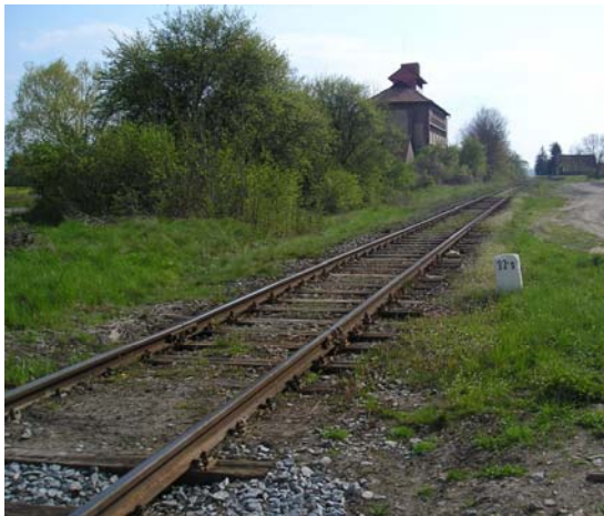
Pohled směr Moravany na 33,900 km
