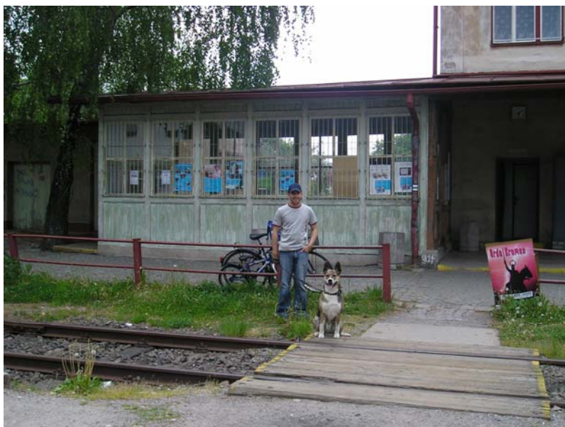
Železniční stanice Holice
