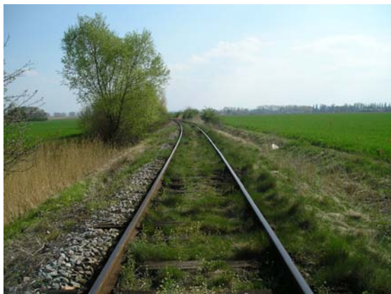
Pohled směr Borohrádek na 32,500 km
