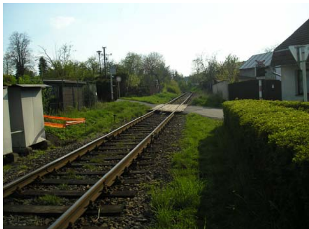
Pohled směr Moravany, trať zde prochází zahrádkářskou kolonií
