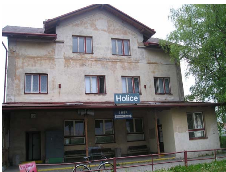
Železniční stanice Holice – výpravní budova
