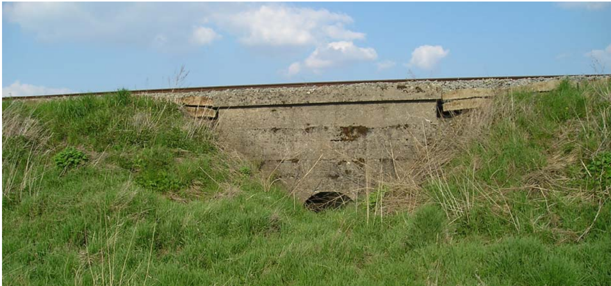
Propustek na 38,087 km
