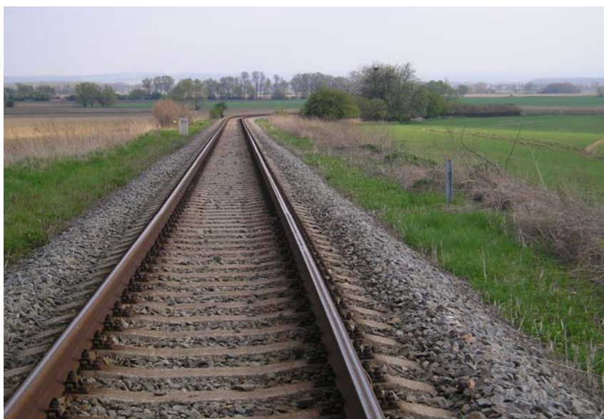
Pohled směr Moravany směr 37,000 km
