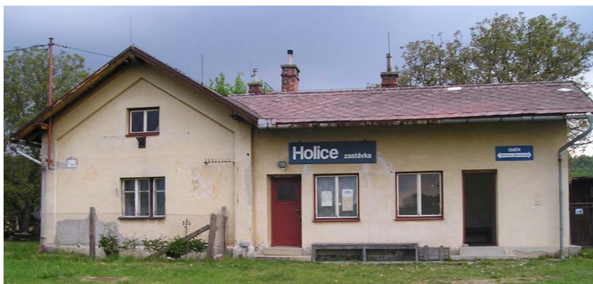
Zastávka Holice, detailní pohled
