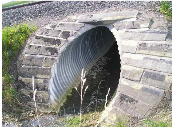
Zrekonstruovaný propustek 33,070 km
