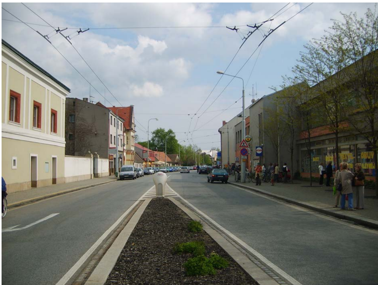
Obr. 7 Silnice I/36 příjezd k okružní křižovatce ze směru Pardubice
