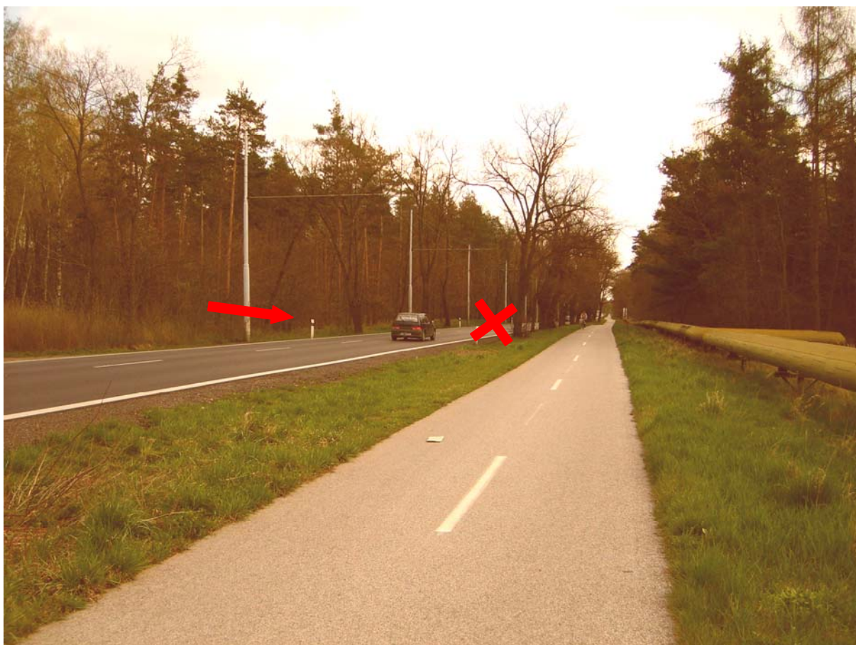
Obr. 6 Stávající stav I/36 – místo křížení s budoucí komunikací
