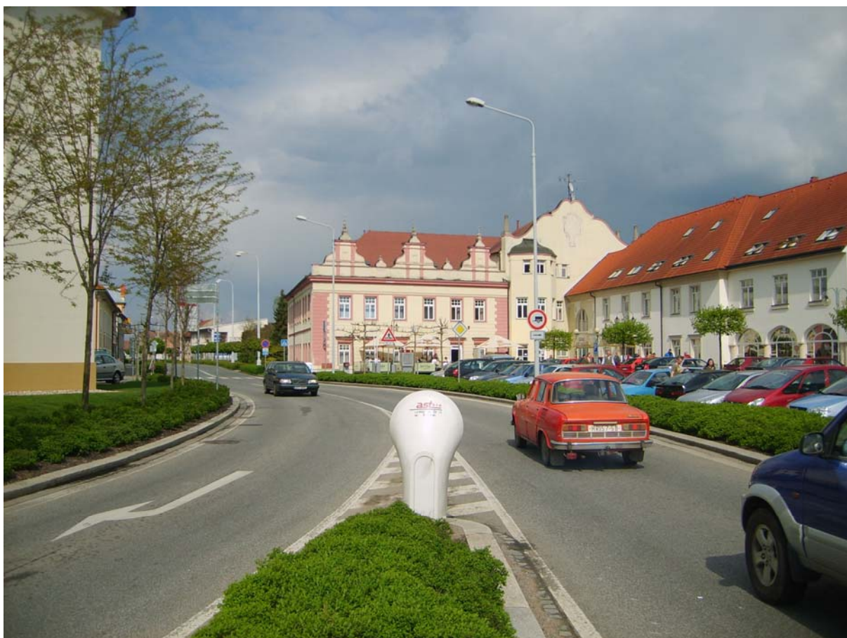
Obr. 6 Silnice II/333 příjezd k okružní křižovatce ze směru Hradec Králové
