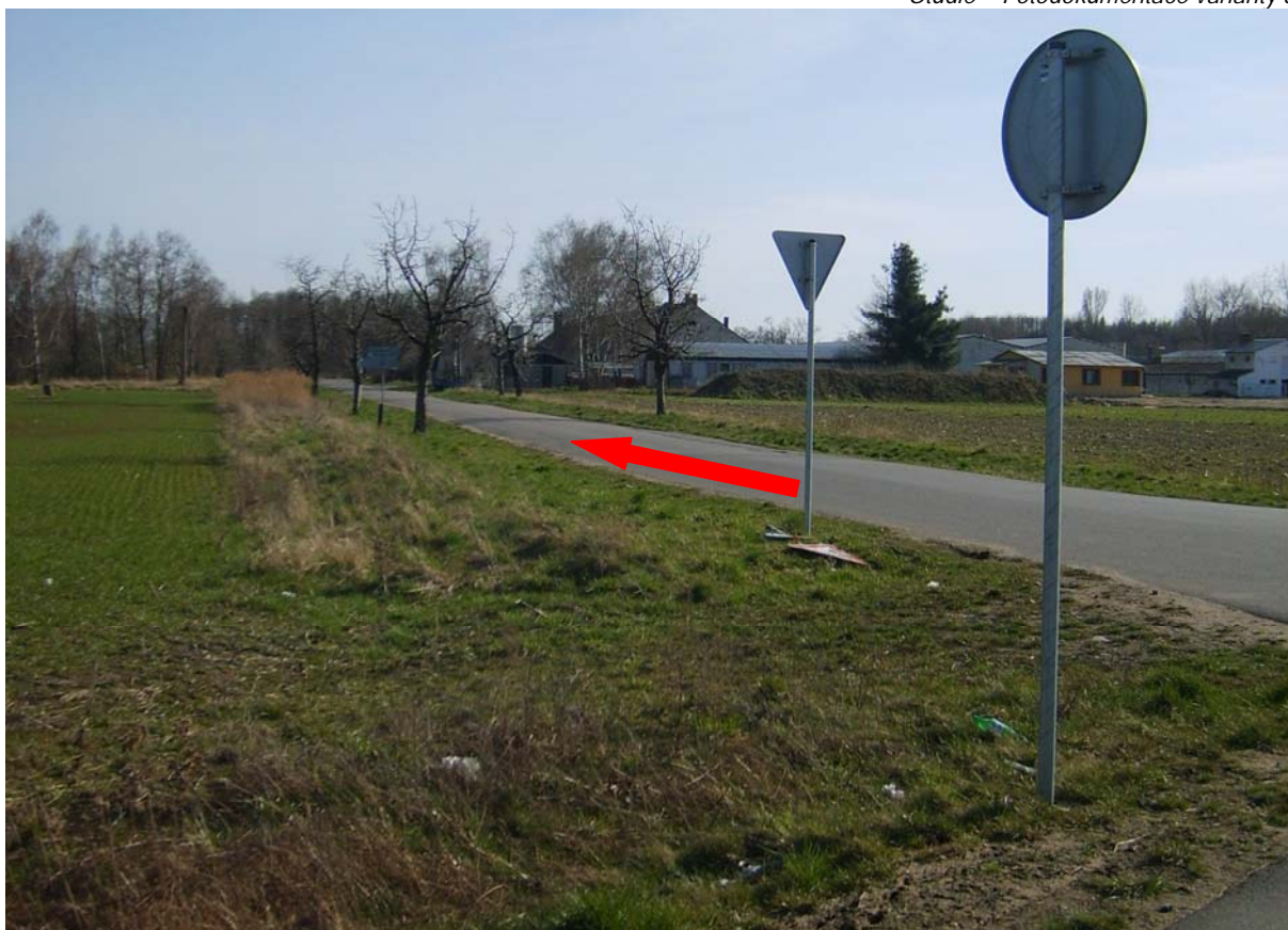
Obr. 3 Stávající stav III/32225 – vedení budoucí komunikace
