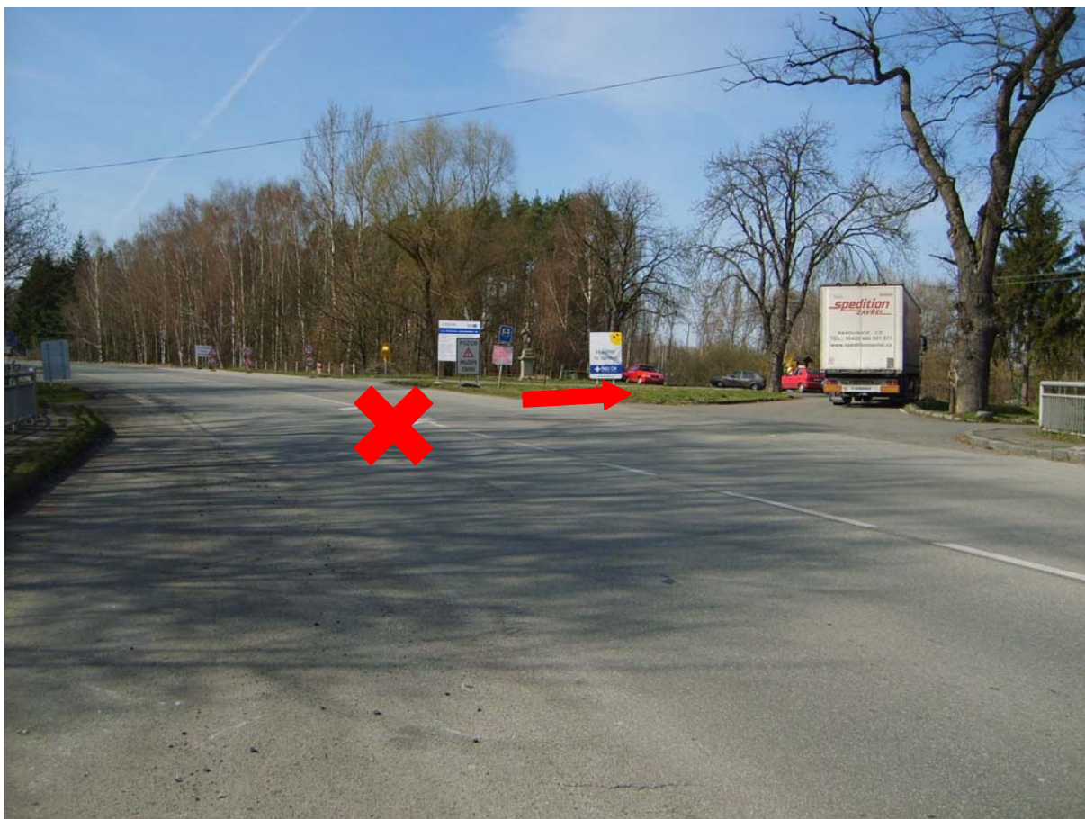
Obr. 1 Stávající stav I/36 – místo křížení s budoucí komunikací
