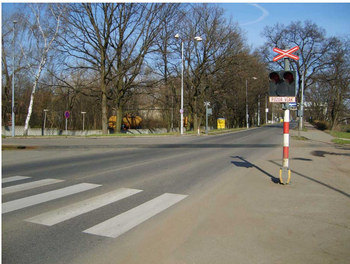
Obr. 18 Stávající stav – konec řešeného úseku
