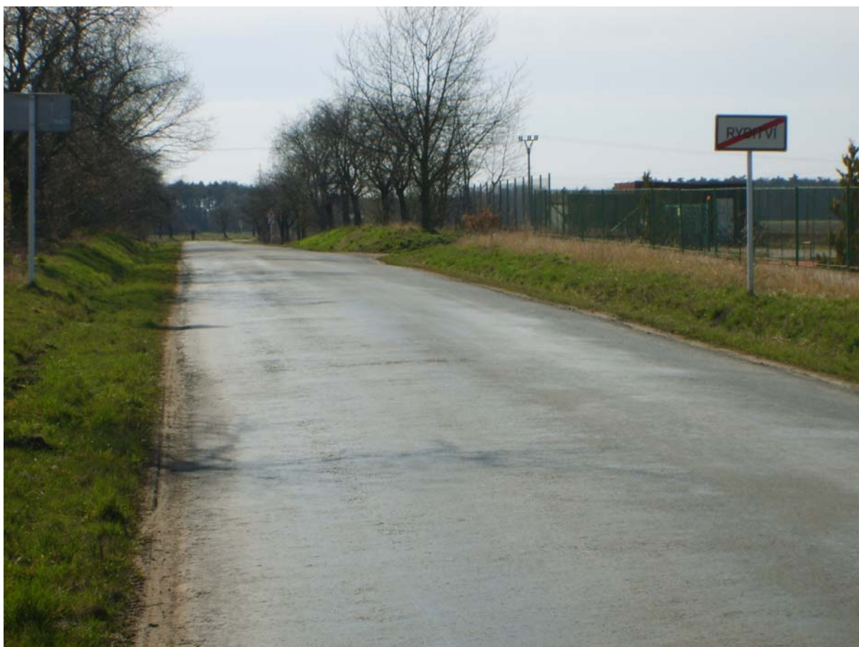
Obr. 6 Stávající stav komunikace III/32225
