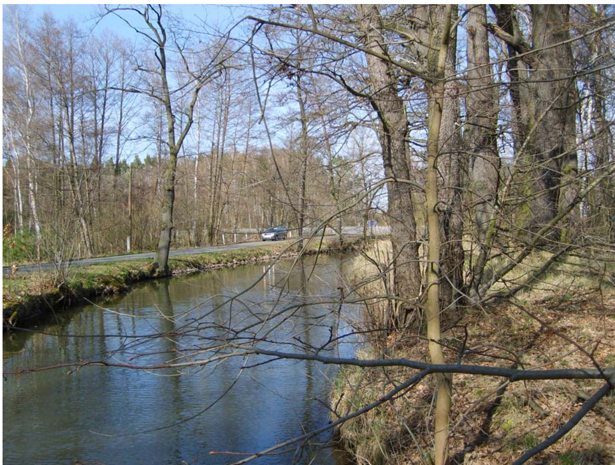
Obr. 4 Opatovický kanál – most 0.08503 km
