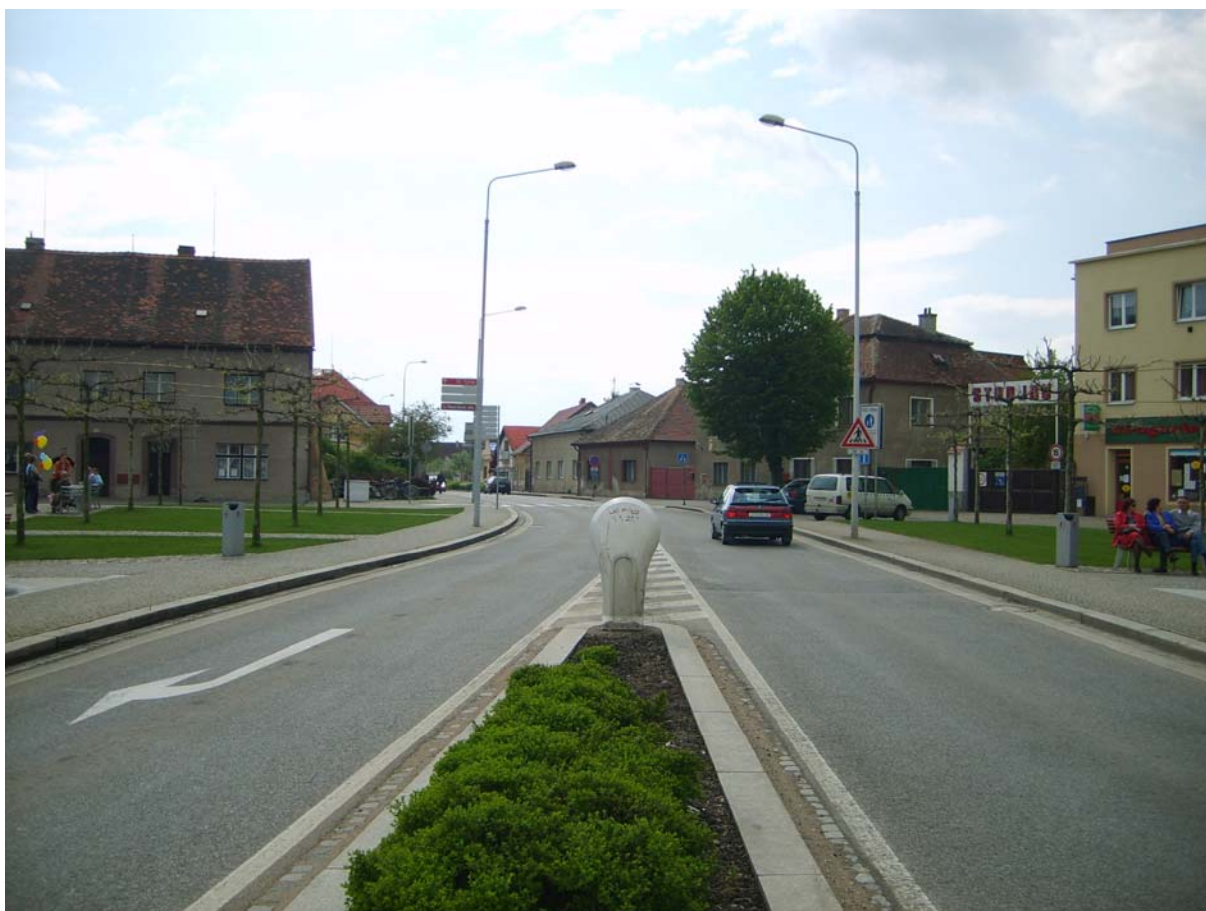
Obr. 8 Silnice II/333 příjezd ze směru Pílovice
