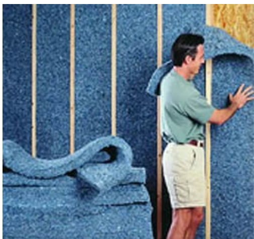
Obr.18. Umisťování recyklované džínsovinny do obvodového pláště
