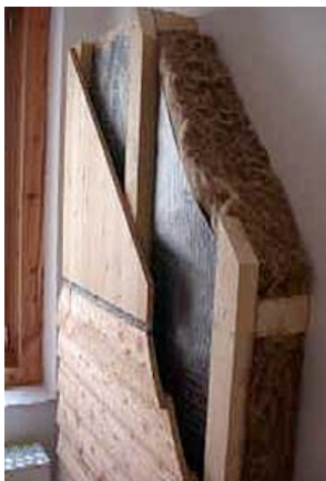
Obr.17. Skladba zdi s použitím slaměné izolace
