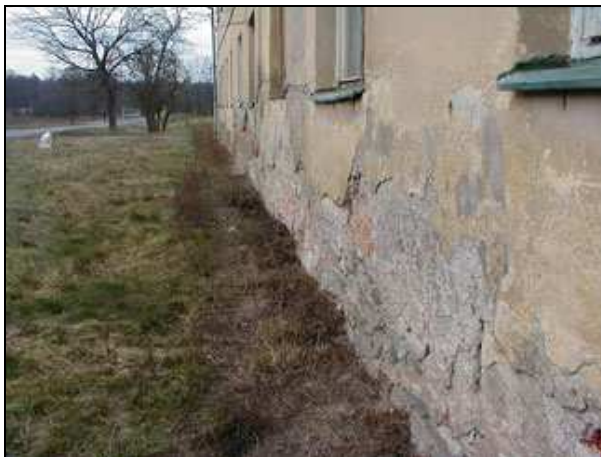
Obrázek 4: Kapilární, vztlínající základová vlhkost. Zdroj [5]
