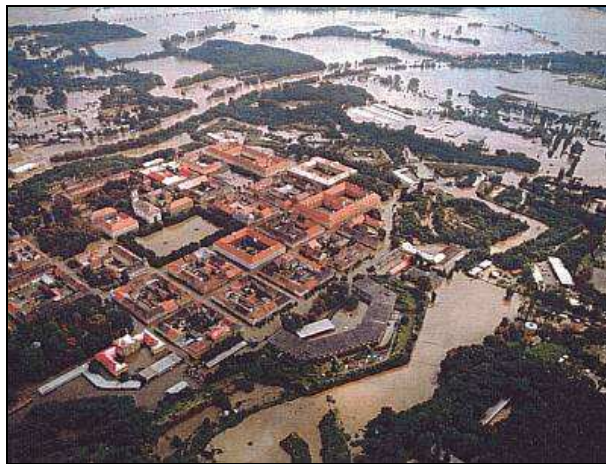
Obrázek 2: Zaplavené město Terezín. Zdroj [2]
