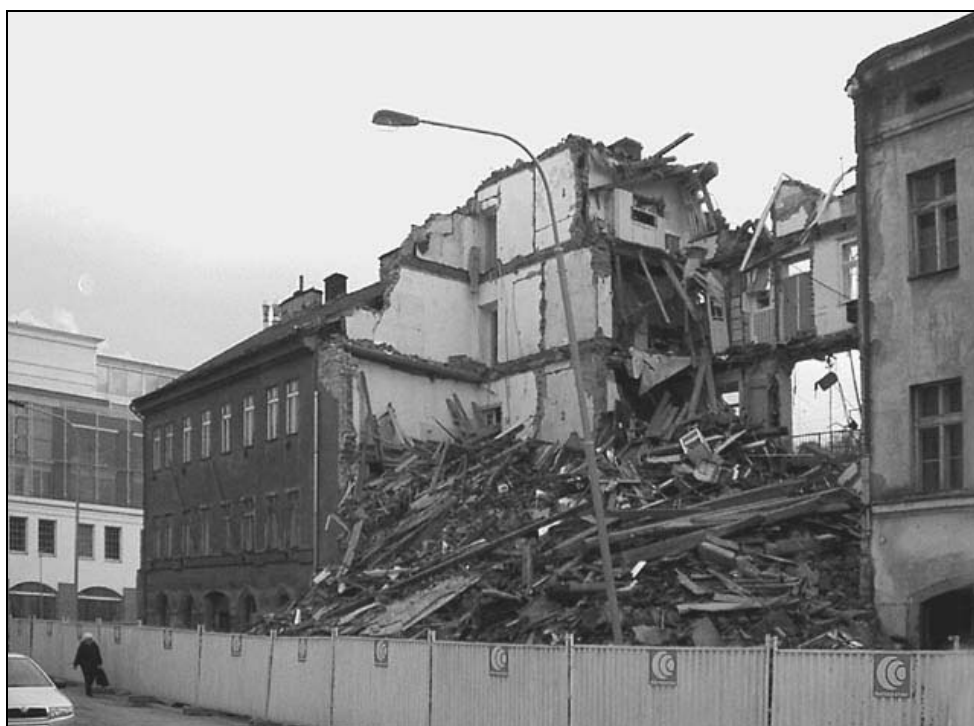
Obrázek 1: Zřícená přední část domu čp. 148 v Křížkové ulici. Zdroj [9]
