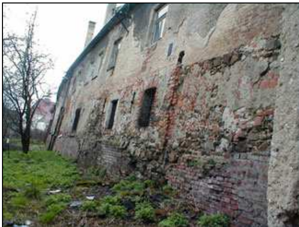
Obrázek 10: Vlhkost z dopadajícího deště. Zdroj [5]
