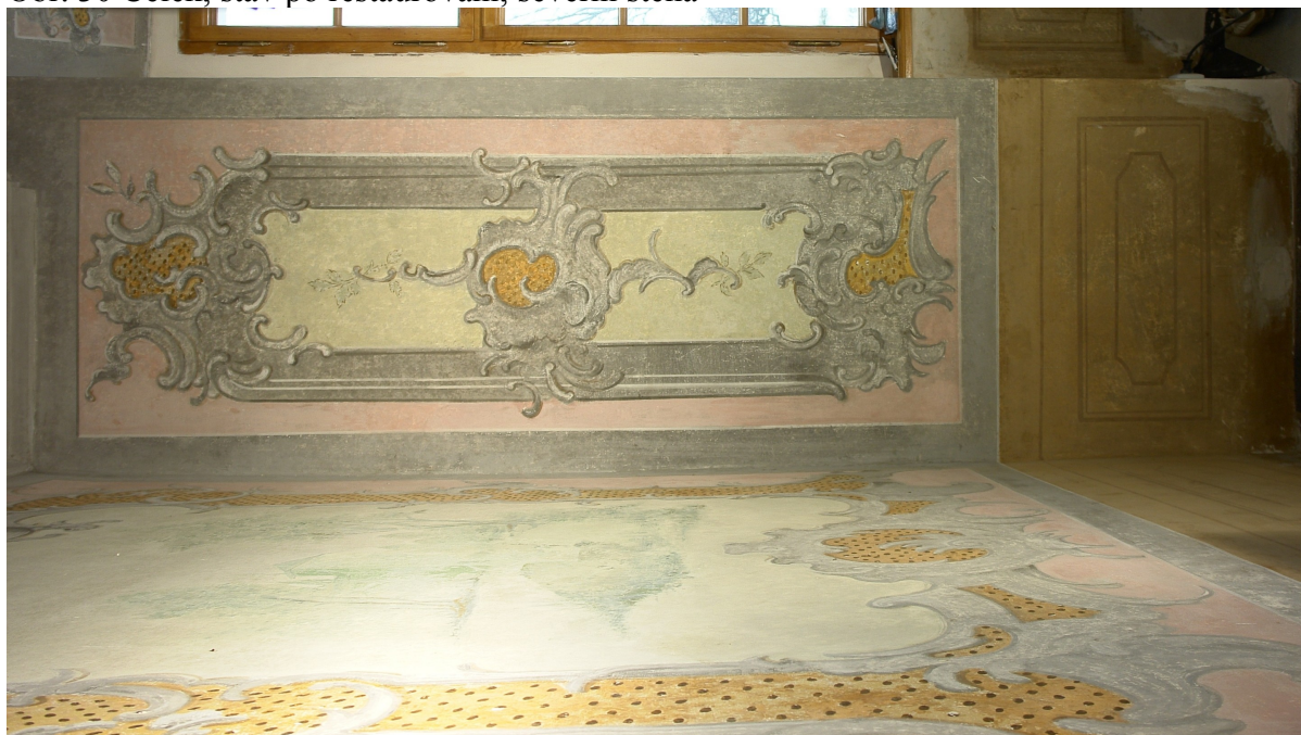
Obr. 31 Celek, stav před restaurováním, severní stěna
