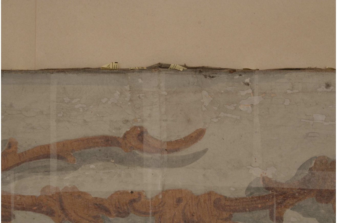
Obr.12. Stav před restaurováním, líc objektu, detail poškození
