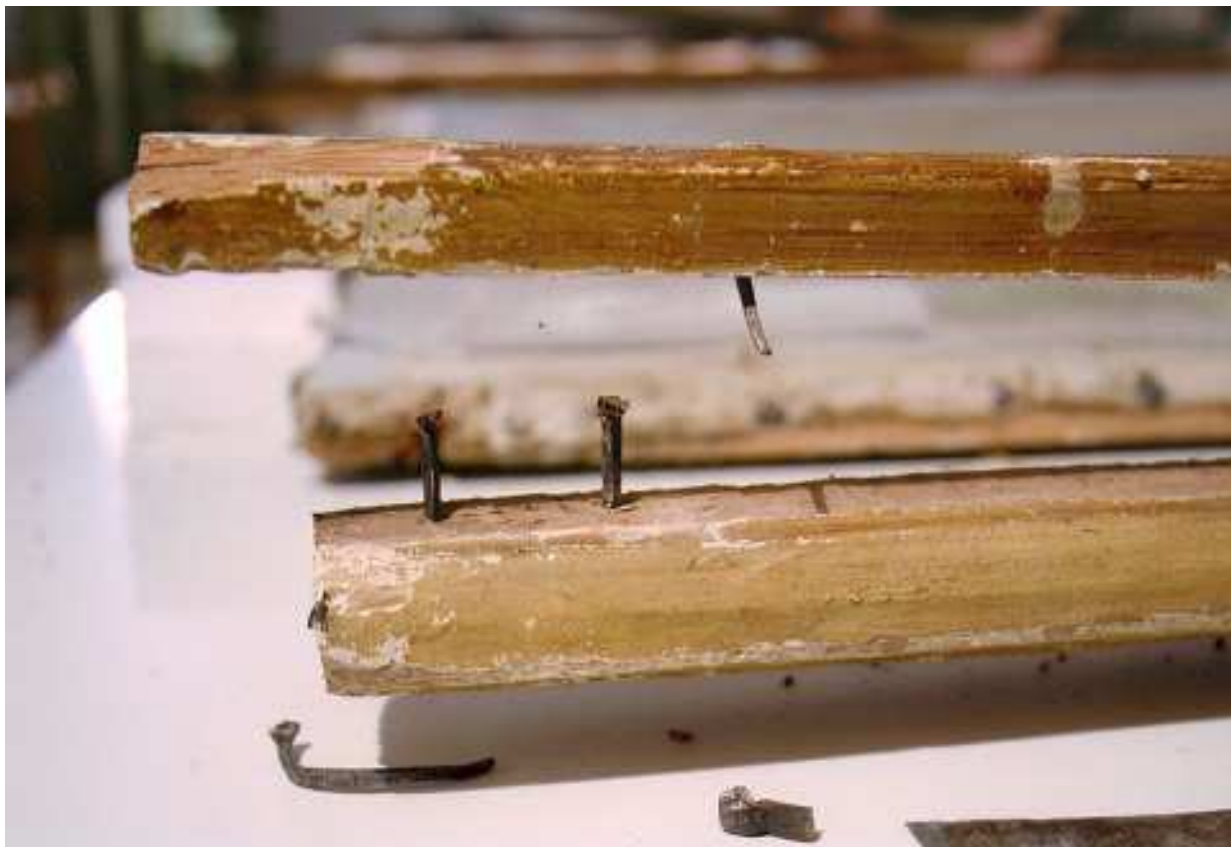
Obr.14. Průběh restaurování, snímání dolní dřevěné lišty, detail
