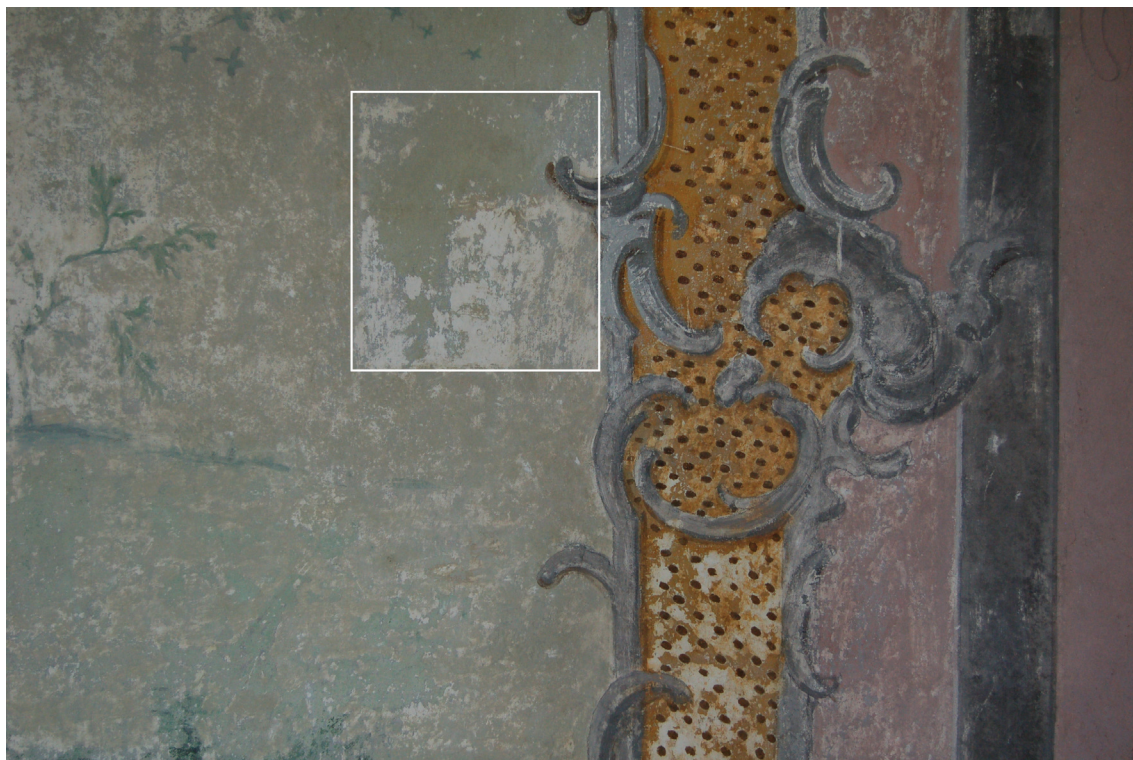
obr. 17: Zkouška čištění s koňskými žíněmi, sonda v oblasti ústředního motivu krajiny
