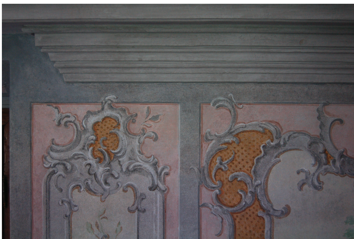
obr. 20: Levá horní část dekoru, detail rokajů po restaurování
