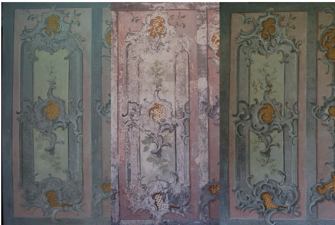
obr. 19: Srovnání levé části dekoru před, v průběhu a po restaurování
