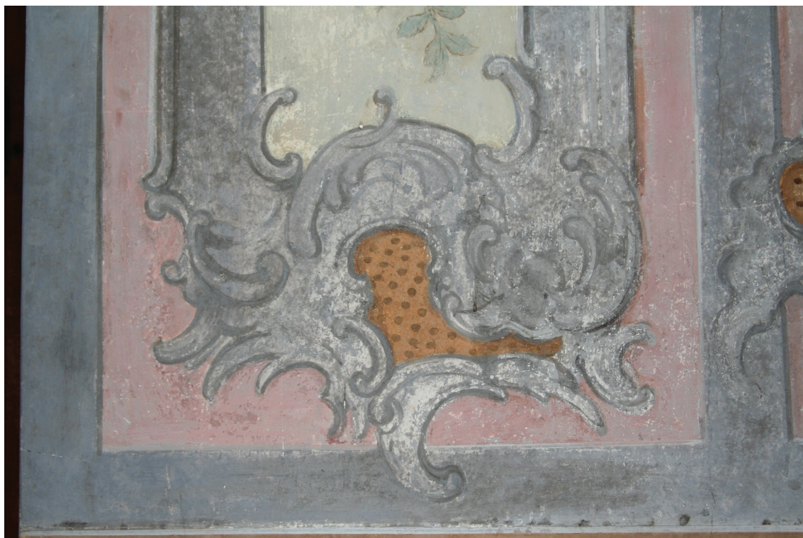
obr. 7: Vizuální průzkum, stav levého dolního rokaje před restaurováním
