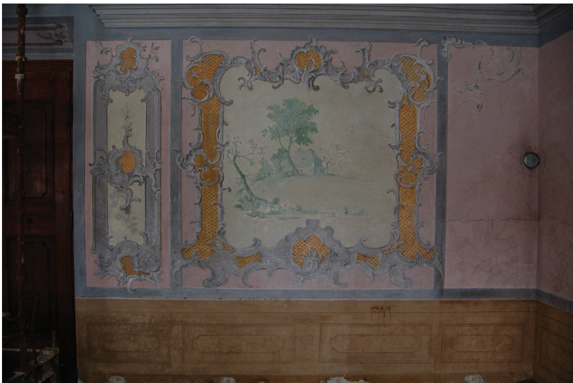
obr. 4: Jižní stěna, pravá část, stav před restaurováním
