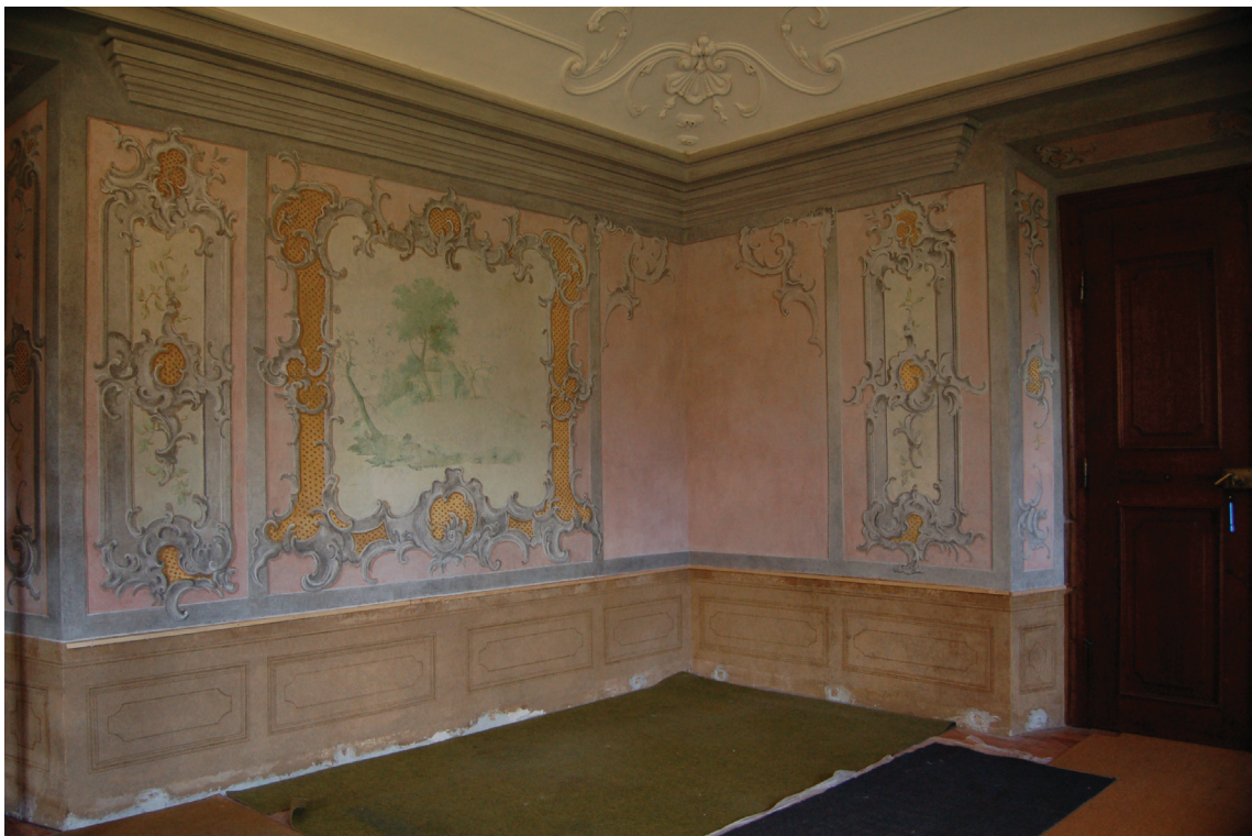
obr. 30: Pohled na jižní stěnu, pravou část po restaurování
