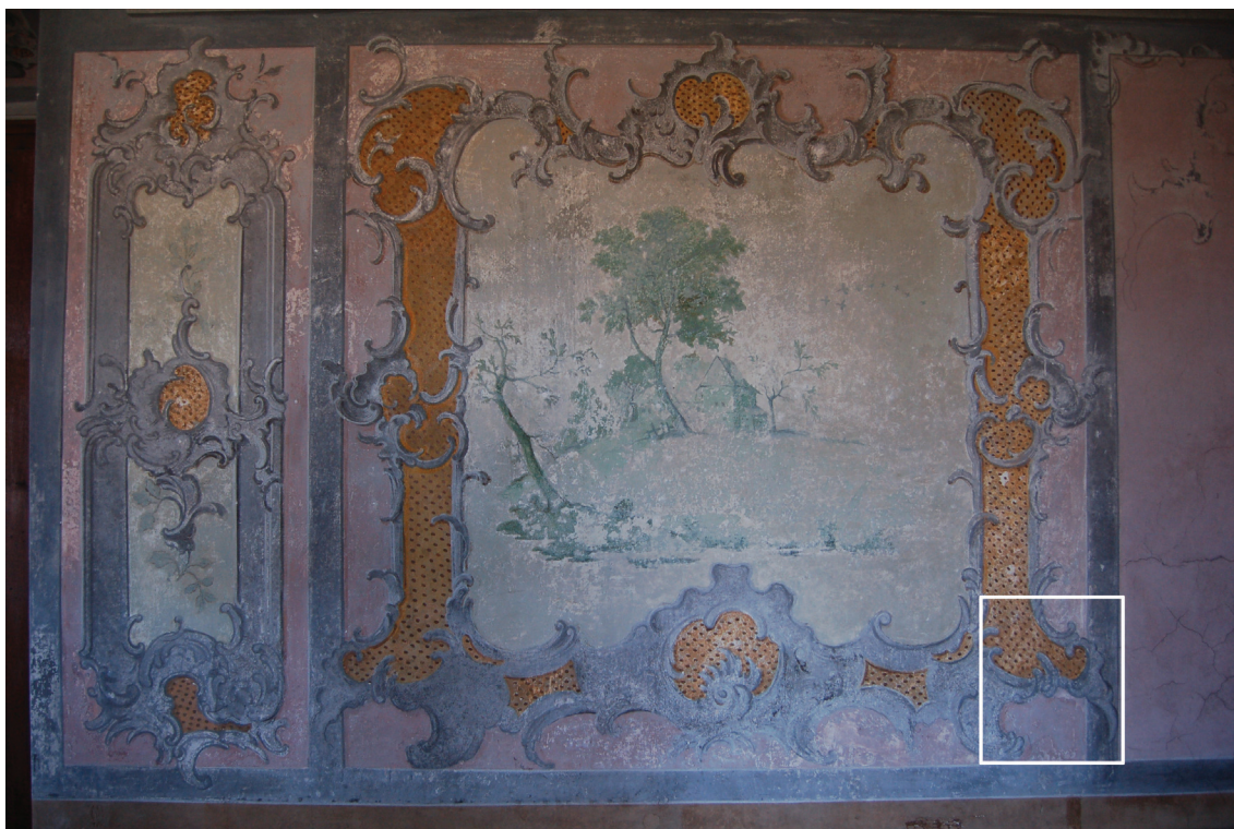
obr. 5: Injektované místo v pravém dolním rohu rokaje
