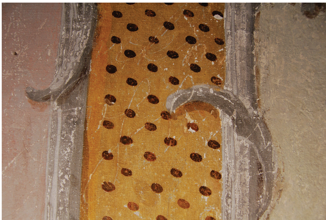
obr. 16: Zkouška čištění s houbou wishab, okrová část
