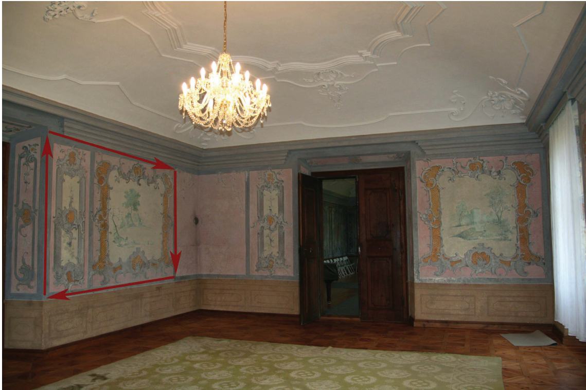
obr. 3: Pohled do sálu č. 116 v 2. NP s vyznačenou jižní stěnou, stav před restaurováním
