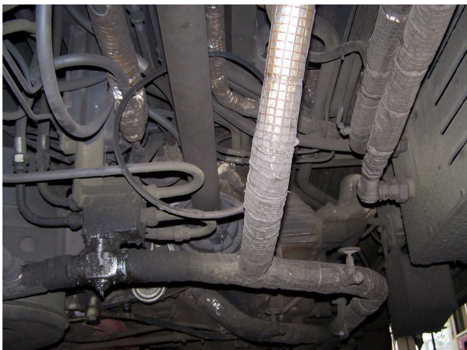
Obr. 31 – Pohled na jeden z konstrukčních uzlů vodního hospodářství. V popředí regulátor hydrostatického pohonu ventilátoru
